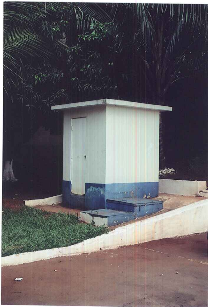
ABRIGO DO POÇO ARTESIANO
