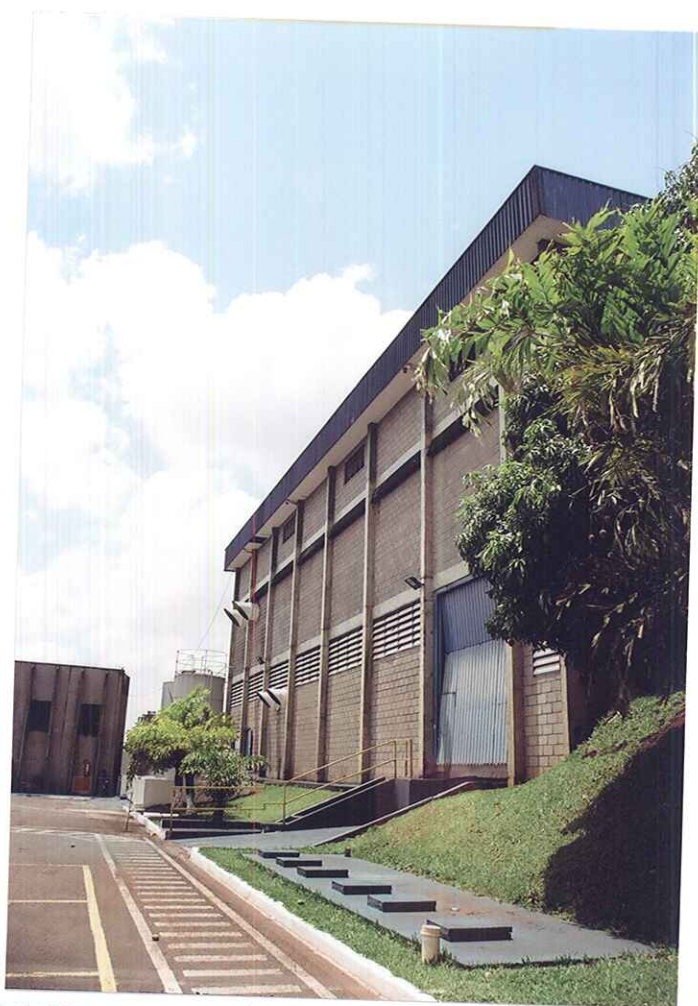
FACHADA DO PRÉDIO DO PREPARO DE TINTAS E DOS ESCRITÓRIOS DA PRODUÇÃO
