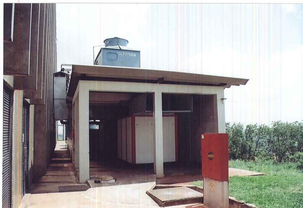
PRÉDIOS DAS TORRES DE RESFRIAMENTO
