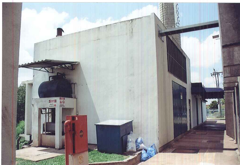
PRÉDIO DO GERADOR
