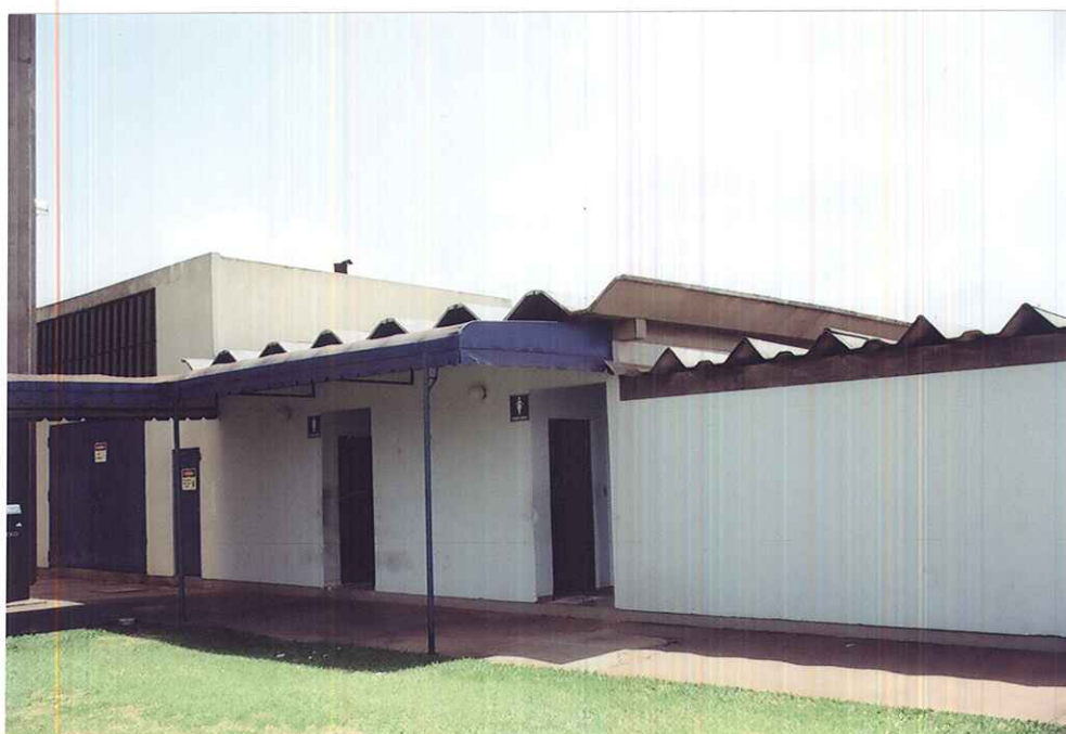
PRÉDIO DOS SANITÁRIOS DA FÁBRICA
