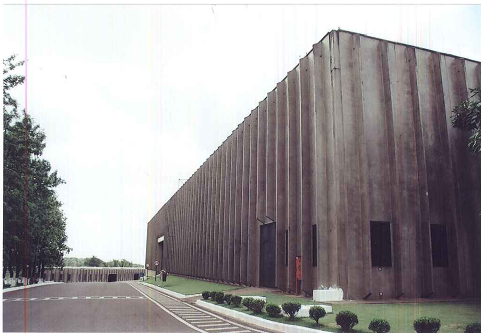
FACHADA LATERAL ESQUERDA DO PRÉDIO INDUSTRIAL, VISTA EM DIREÇÃO AO PRÉDIO DA GARAGEM E DAS OFICINAS (AO FUNDO)
