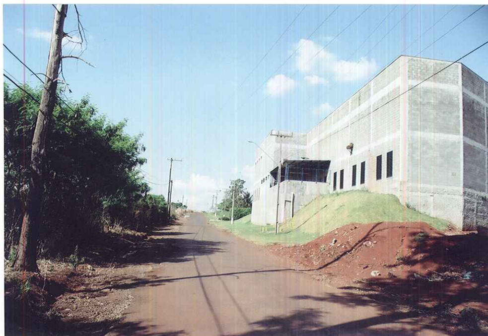
ESTRADA CARANÁ DEFRONTE A LATERAL ESQUERDA DO IMÓVEL (À DIREITA), VISTA TOMADA NO SENTIDO RODOVIA/ FERROVIA
