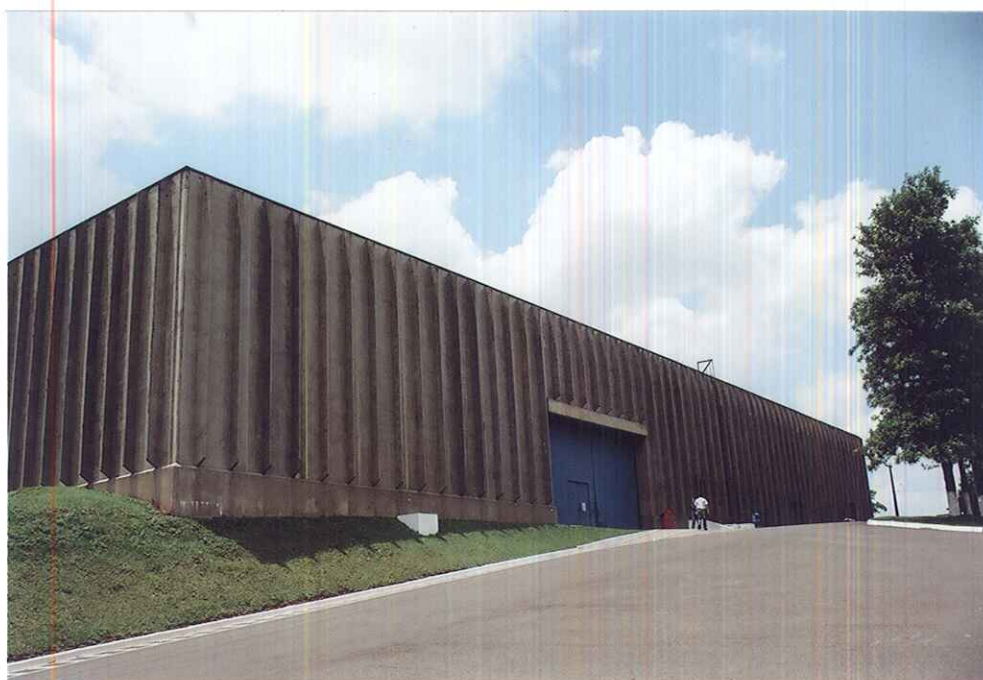
FACHADA LATERAL ESQUERDA DO PRÉDIO INDUSTRIAL, VISTA TOMADA EM DIREÇÃO À FRENTE DO IMÓVEL (RODOVIA)
