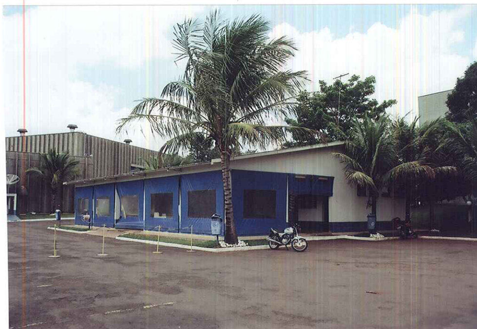
PRÉDIO DA ASSOCIAÇÃO ESPORTIVA
