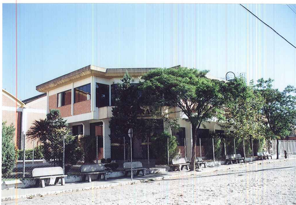
ANTIGO PRÉDIO DE ESCRITÓRIOS
