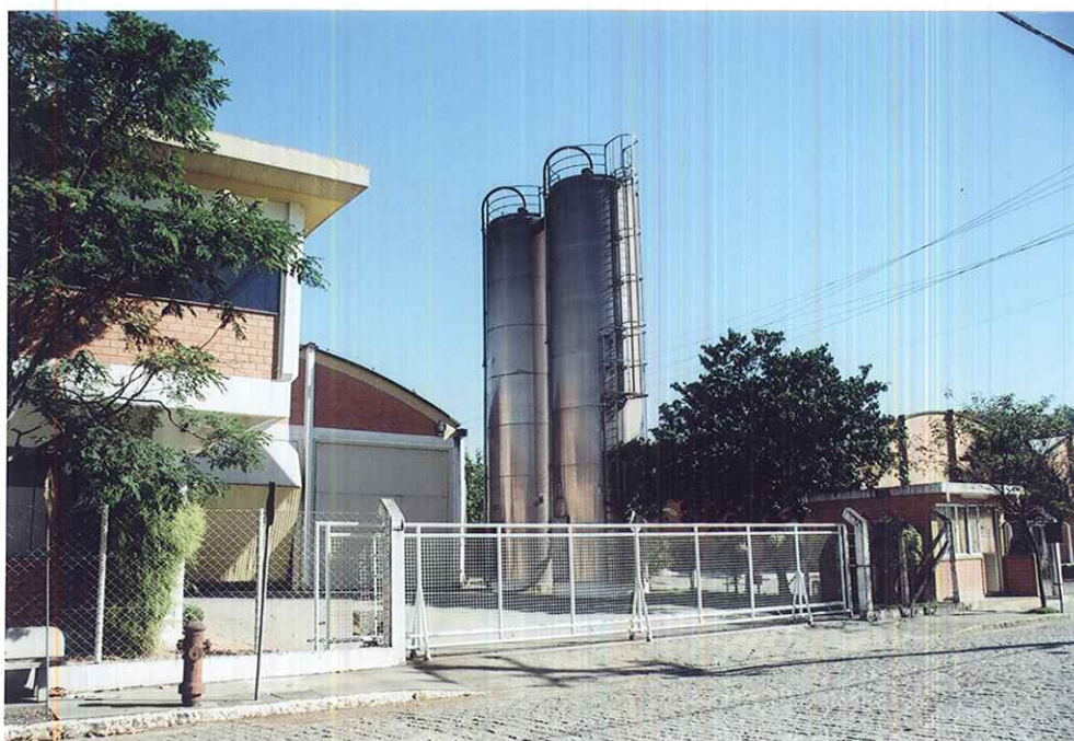
ENTRADA DE VEÍCULOS E TANQUES DE MATÉRIA PRIMA
