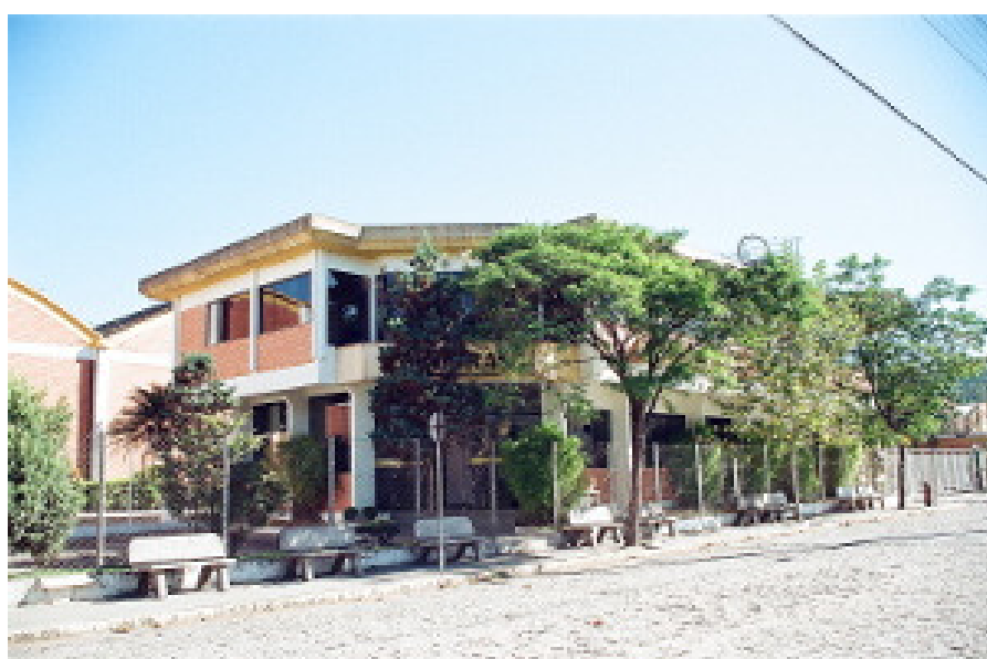
ANTIGO PRÉDIO DE ESCRITÓRIOS
