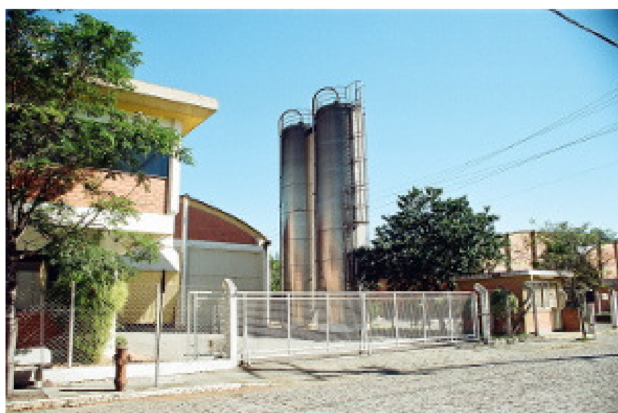
ENTRADA DE VEÍCULOS E TANQUES DE MATÉRIA PRIMA
