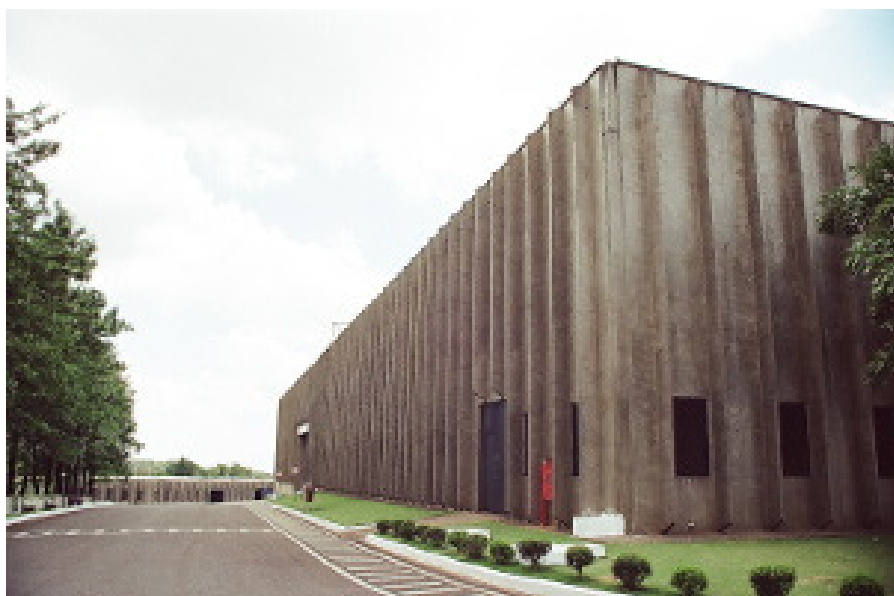
FACHADA LATERAL ESQUERDA DO PRÉDIO INDUSTRIAL, VISTA EM DIREÇÃO AO PRÉDIO DA GARAGEM E DAS OFICINAS (AO FUNDO)
