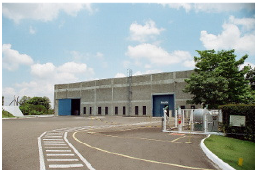
PRÉDIO DO ALMOXARIFADO E DO SETOR DE RECICLAGEM DE RESÍDUOS DO PROCESSO
