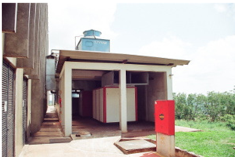
PRÉDIOS DAS TORRES DE RESFRIAMENTO
