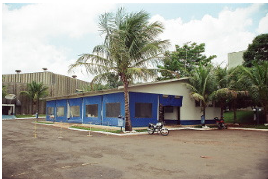
PRÉDIO DA ASSOCIAÇÃO ESPORTIVA
