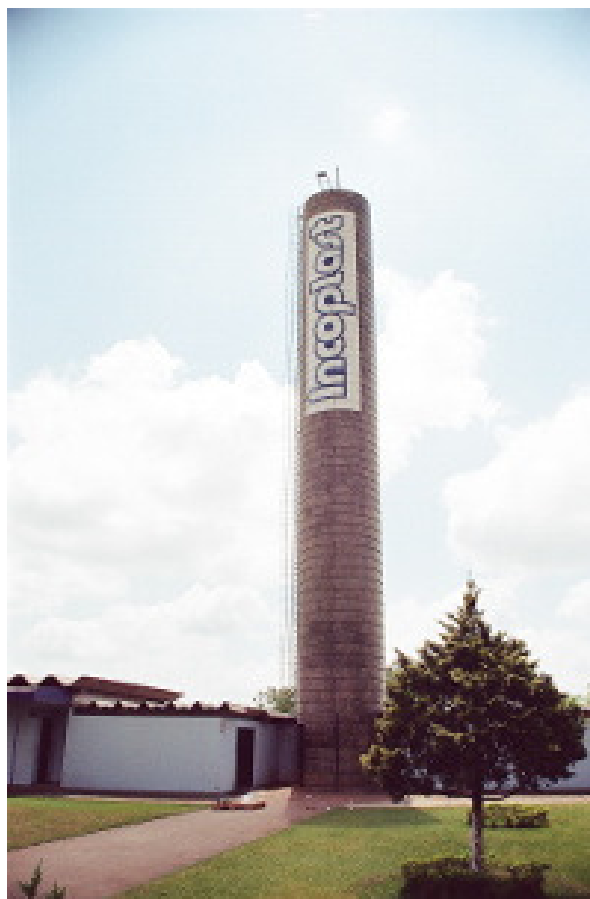
CAIXA D' ÁGUA ELEVADA
