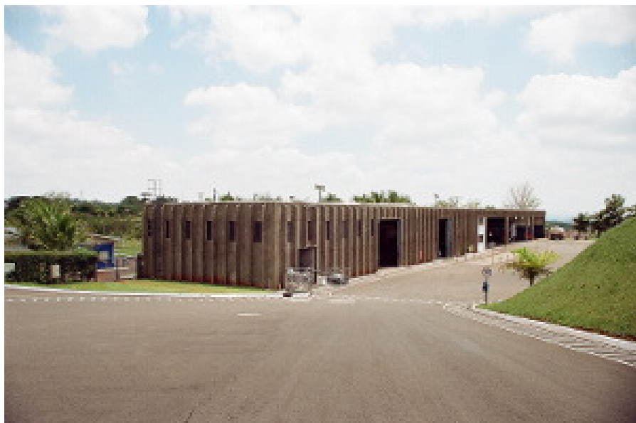
PRÉDIO DA GARAGEM E DAS OFICINAS
