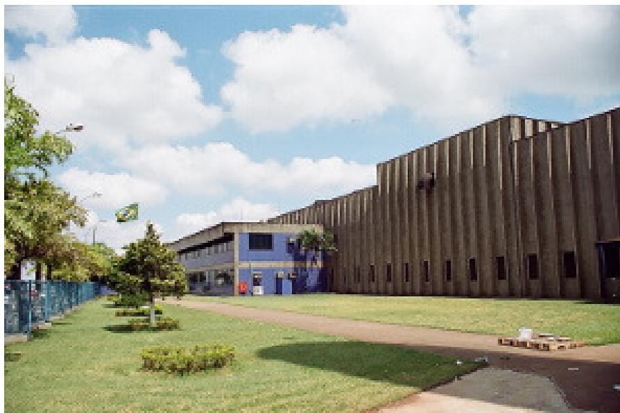
FRENTE DO PRÉDIO INDUSTRIAL
