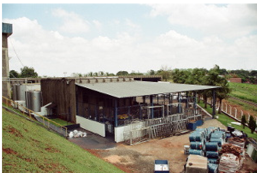
BARRACÃO DE RESÍDUOS
