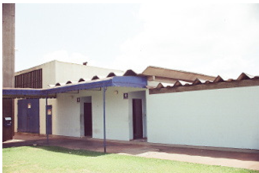
PRÉDIO DOS SANITÁRIOS DA FÁBRICA
