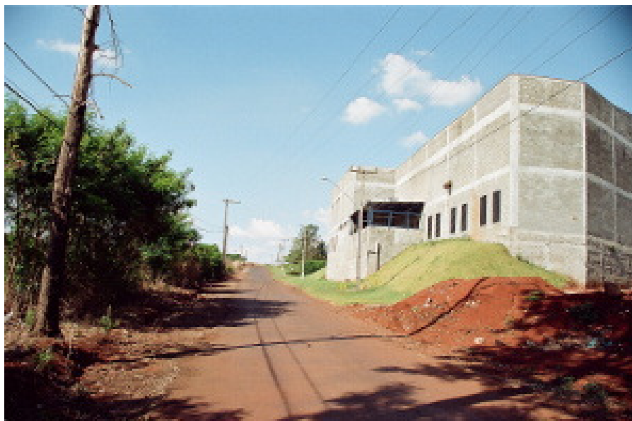
ESTRADA CARANÁ DEFRONTE A LATERAL ESQUERDA DO IMÓVEL (À DIREITA), VISTA TOMADA NO SENTIDO RODOVIA/ FERROVIA
