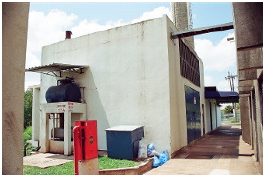
PRÉDIO DO GERADOR
