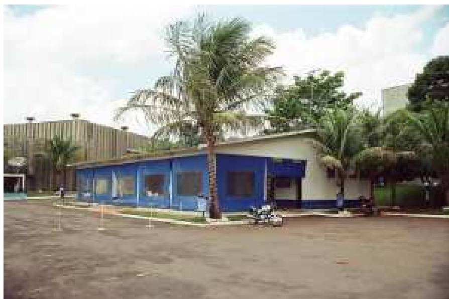
PRÉDIO DA ASSOCIAÇÃO ESPORTIVA
