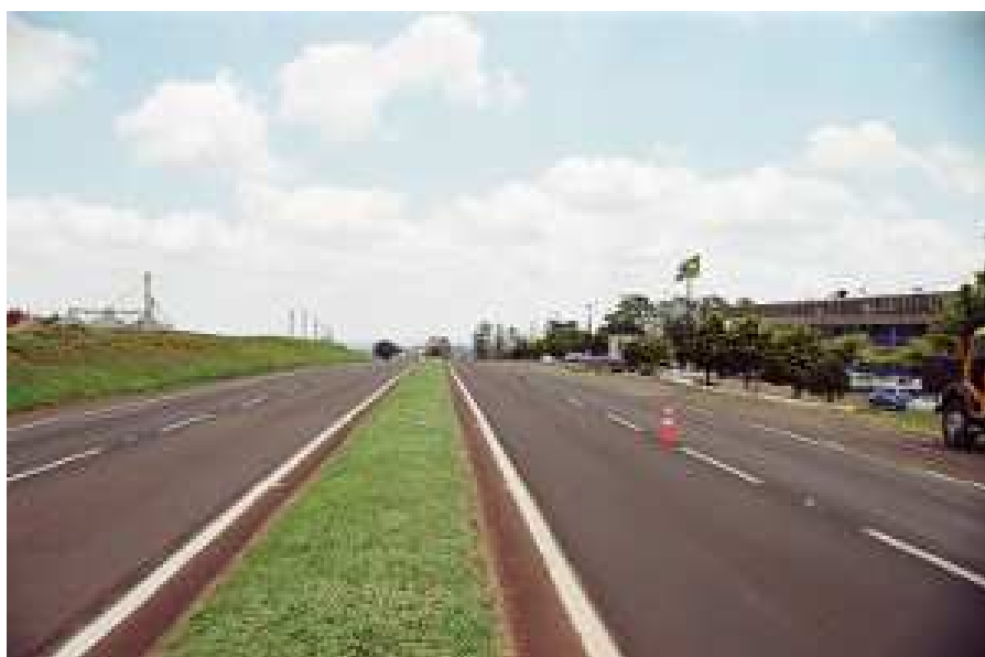
RODOVIA BR 376 (CONTÔRNO SUL) DEFRONTE O IMÓVEL AVALIADO (À DIREITA), VISTA TOMADA NO SENTIDO LONDRINA/ MARINGÁ
