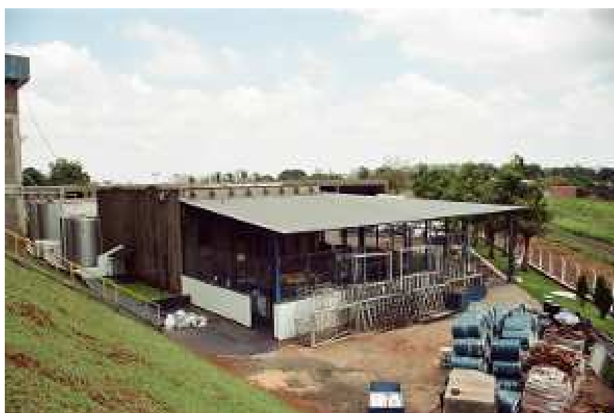
BARRACÃO DE RESÍDUOS
