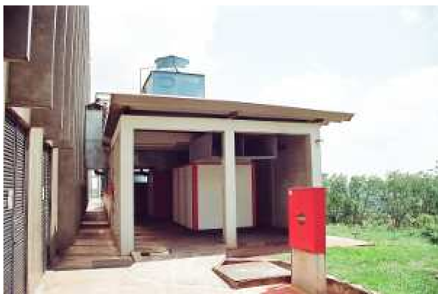
PRÉDIOS DAS TORRES DE RESFRIAMENTO
