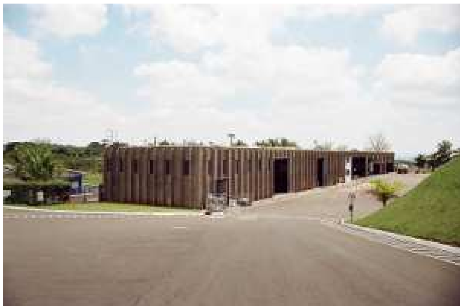
PRÉDIO DA GARAGEM E DAS OFICINAS
