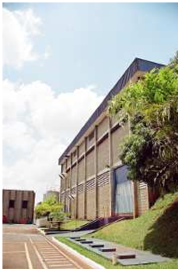
FACHADA DO PRÉDIO DO PREPARO DE TINTAS E DOS ESCRITÓRIOS DA PRODUÇÃO
