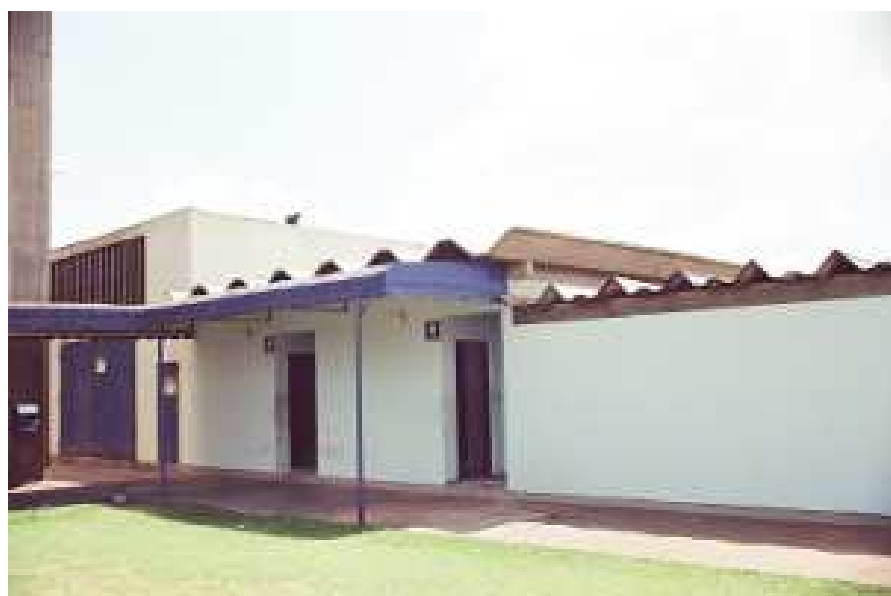
PRÉDIO DOS SANITÁRIOS DA FÁBRICA
