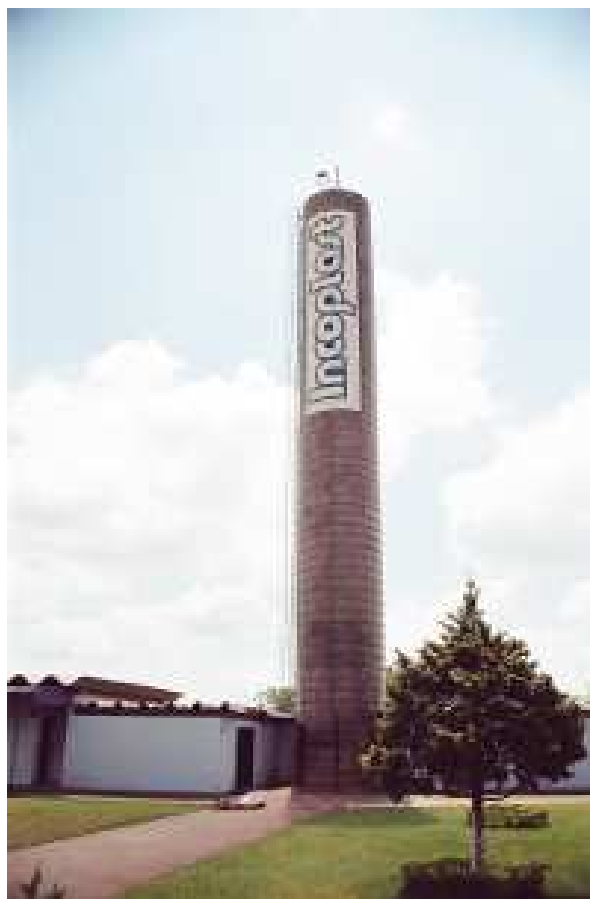
CAIXA D' ÁGUA ELEVADA
