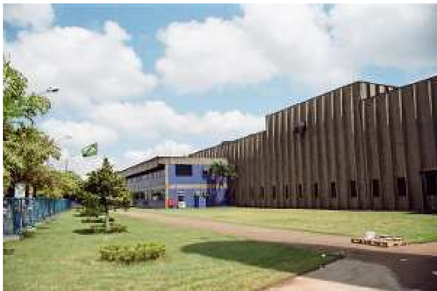
FRENTE DO PRÉDIO INDUSTRIAL
