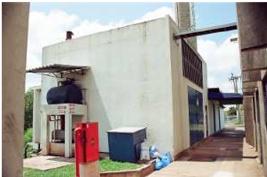
PRÉDIO DO GERADOR
