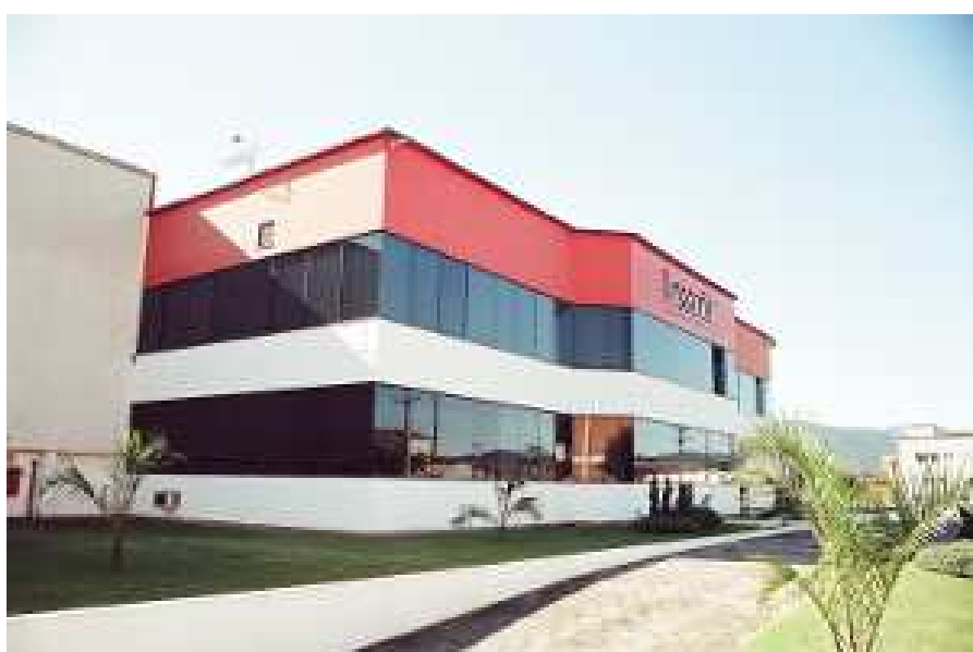
PRÉDIO DE ESCRITÓRIOS
