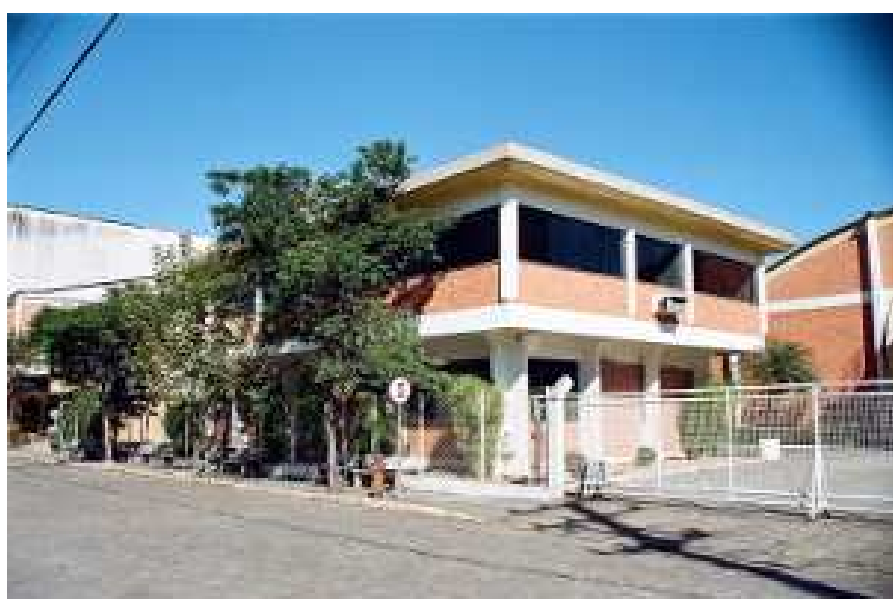
ANTIGO PRÉDIO DE ESCRITÓRIOS
