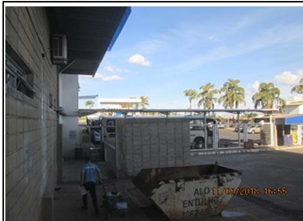
Vista da portaria e das docas.
