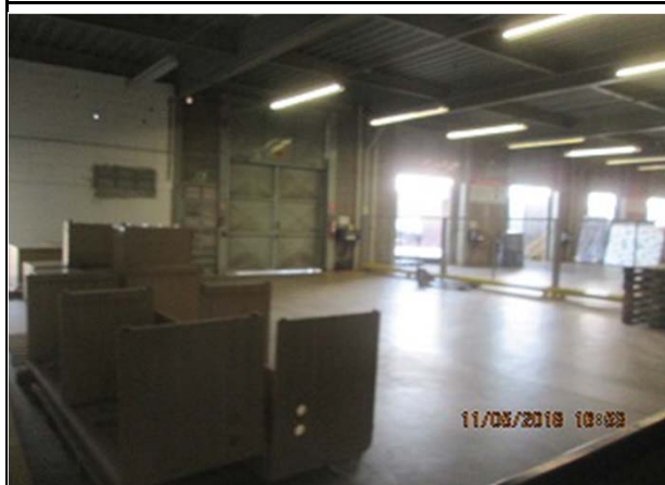
Vista parcial do galpão principal, no térreo.
