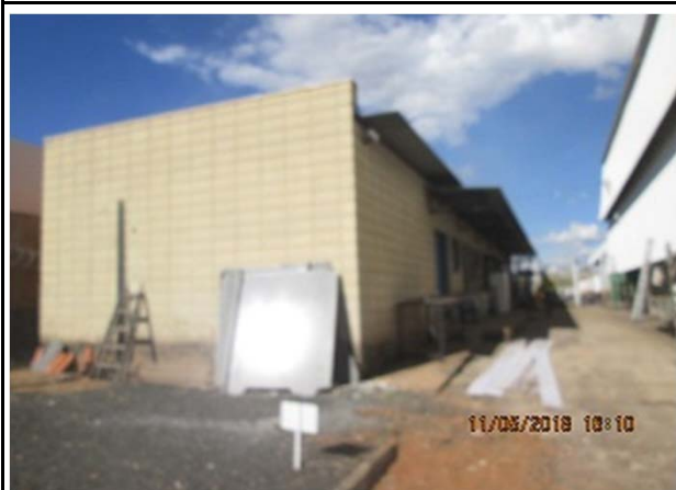
Vista da manutenção.
