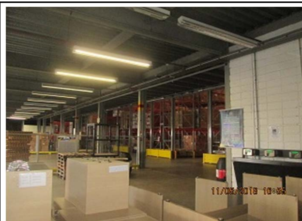
Vista parcial do galpão principal, no térreo.
