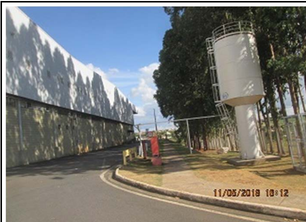
Vista galpão principal, pátio e reservat. "taça".
