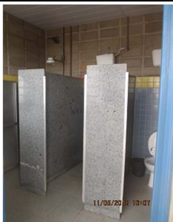
Vista do sanitários, manutenção
