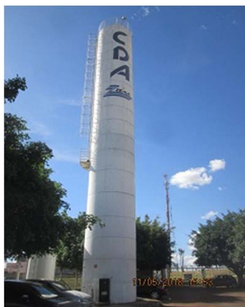
Vista reservatório cilíndrico de 125 m³.
