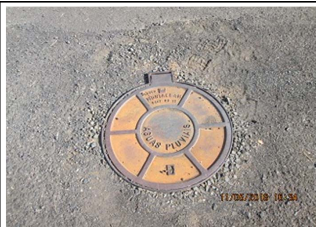
Vista da rede de águas pluviais.
