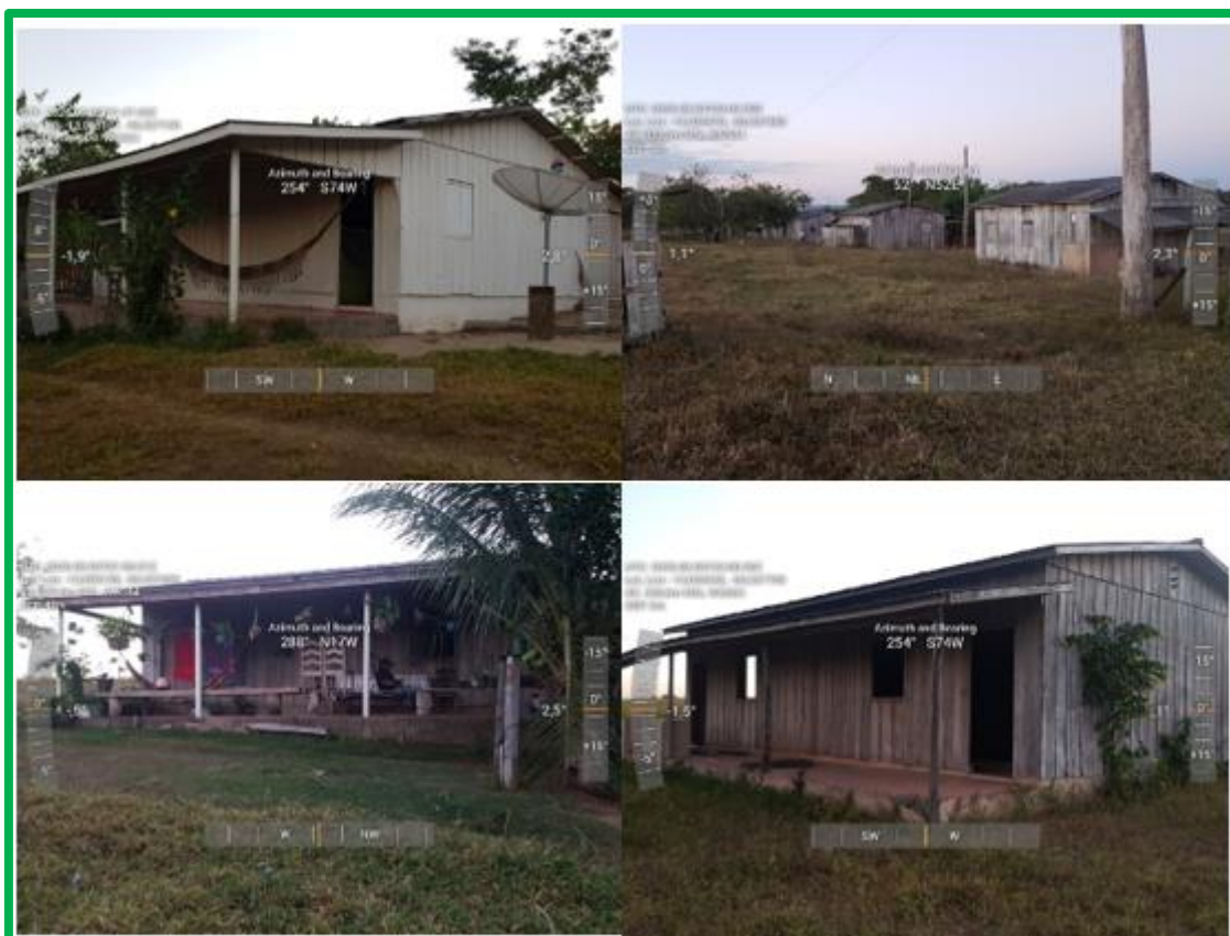
Figura 11 – Casas de funcionário (benfeitoria)
