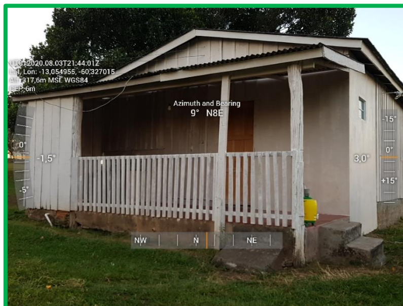
Figura 10 – Vista casa de hospedes (benfeitoria)
