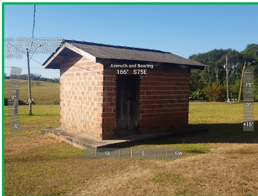
Figura 6 – Vista casa de gerador (benfeitoria)
