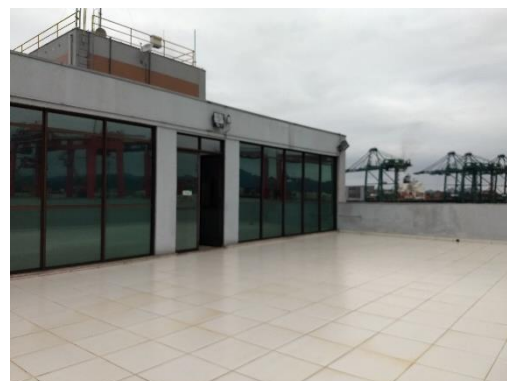
Prédio Adm – terraço – 3º Pav
