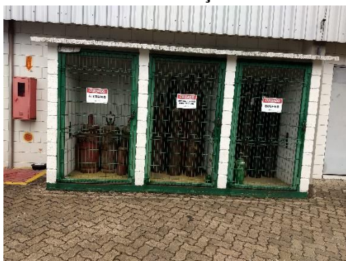
Oficina de manutenção mecânica
