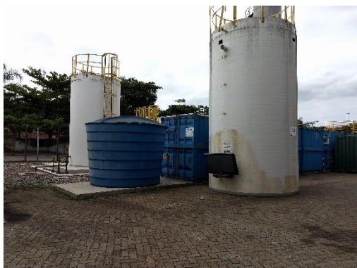
Cisterna / Torre / ETE
