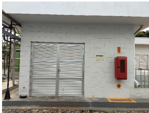
Cisterna / Torre / ETE
