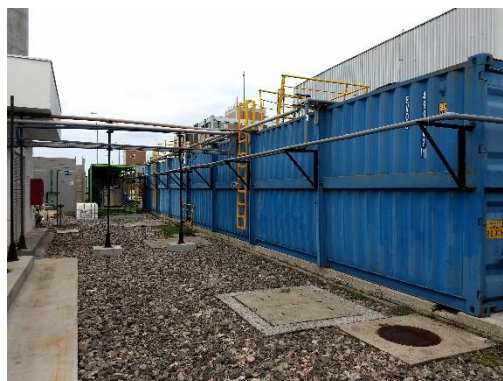
Cisterna / Torre / ETE
