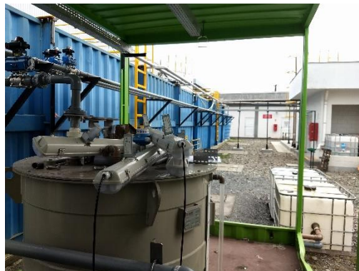
Cisterna / Torre / ETE
