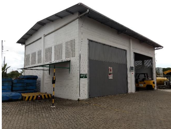
Central de resíduos
