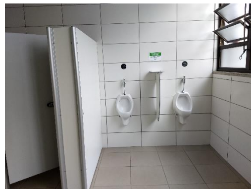
Prédio Adm – sanitário – térreo
