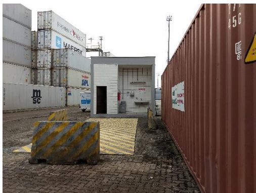
Depósito de emergência ambiental
