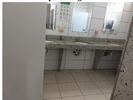
Apoio dos gates – Sanitário
