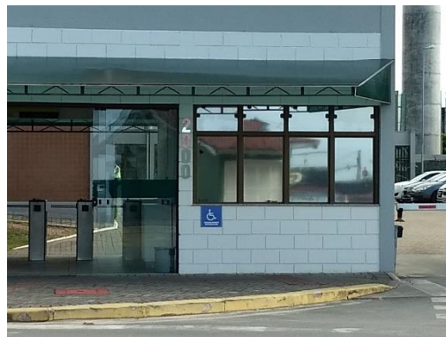
Vista da portaria de acesso
