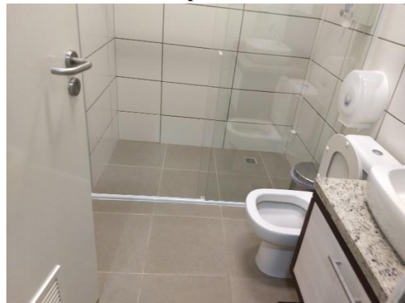
Prédio Adm – sanitários – 2º Pav
