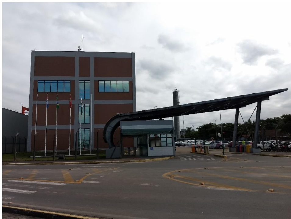
Vista da portaria de acesso ao empreendimento
