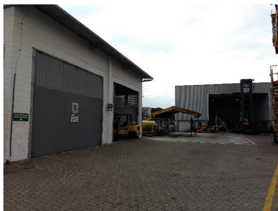
Central de resíduos
