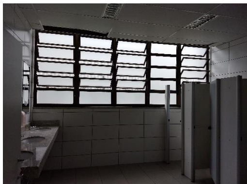
Prédio Adm - sanitário – térreo
