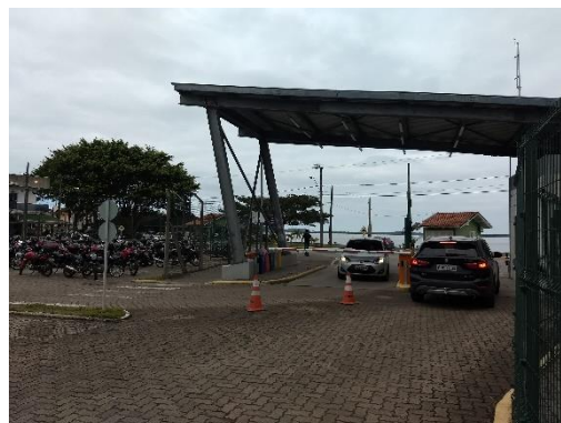
Vista da portaria de acesso
