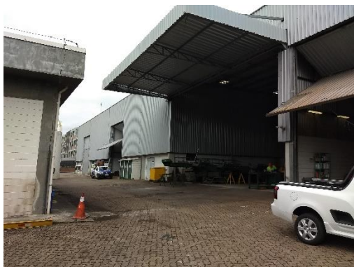
Oficina de manutenção mecânica
