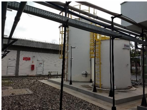
Cisterna / Torre / ETE
