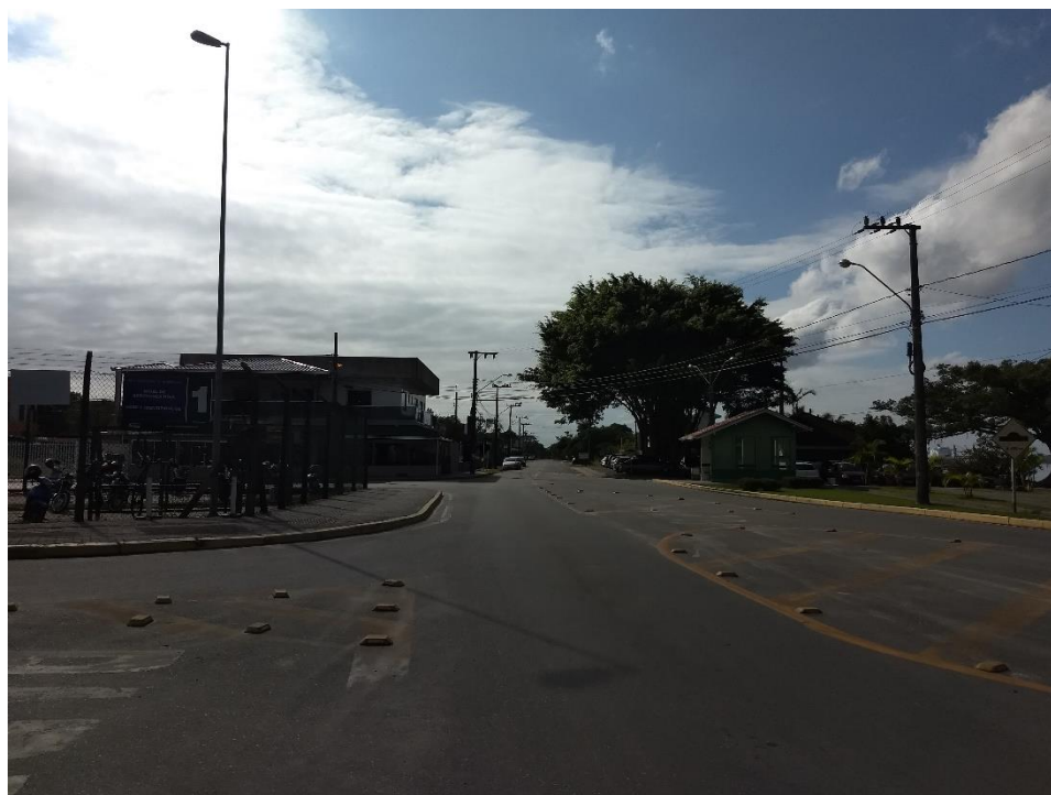
Vista do logradouro da portaria de acesso ao empreendimento
