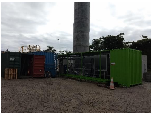
Cisterna / Torre / ETE
