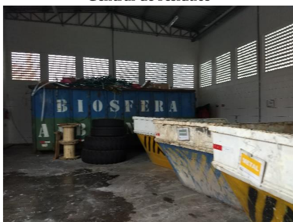
Central de resíduos
