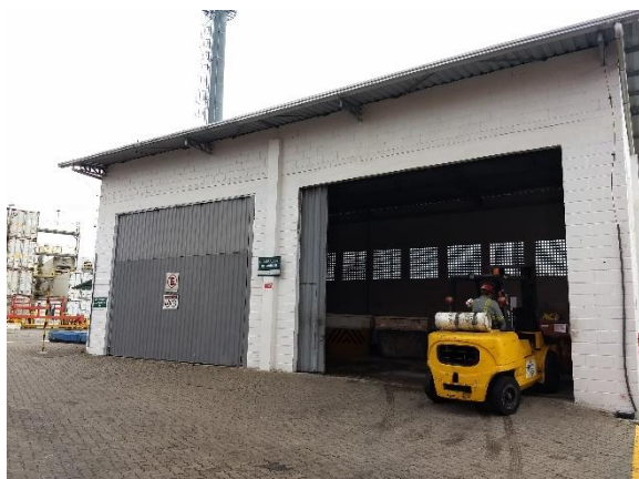
Central de resíduos
