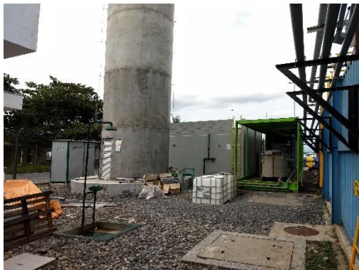
Cisterna / Torre / ETE
