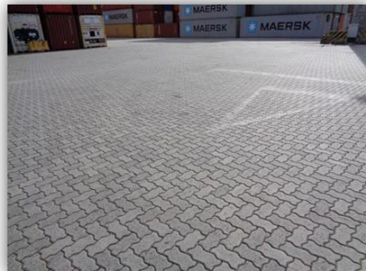
Detalhes da pavimentação externa em blocos intertravados de concreto no pátio de armazenagem de contêineres (2ª Fase - Expansão)
