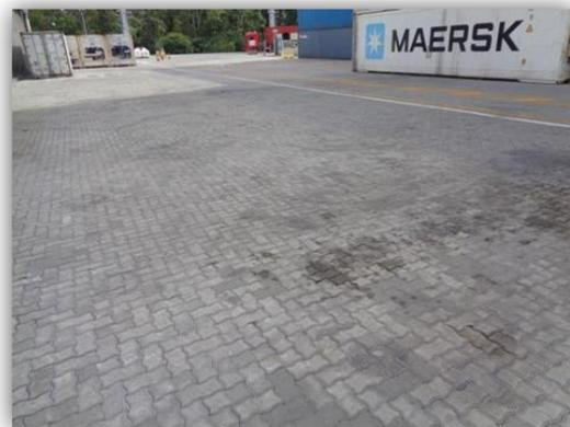
Detalhes da pavimentação externa em blocos intertravados de concreto no pátio de armazenagem de contêineres (3ª Fase – Expansão – Área A + B)
