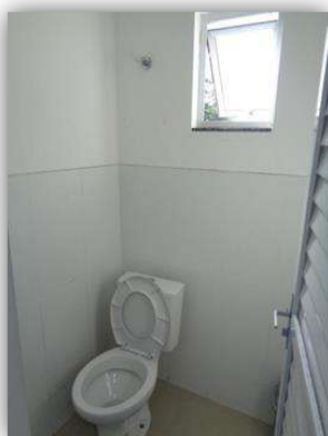
Detalhe interno do banheiro da guarita
