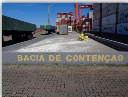
Vistas parciais da bacia de contenção (área próxima ao depósito de emergência ambiental)
