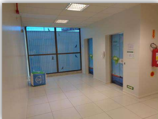
Detalhe do hall dos elevadores no 1º andar
