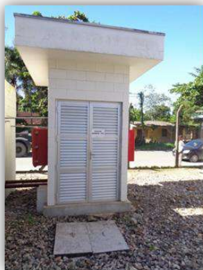
Vista parcial externa da casa de bombas da estação de tratamento de efluentes (ETE)
