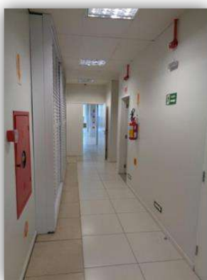
Detalhe do corredor de circulação
