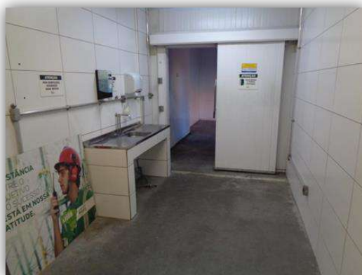
Detalhe da “barreira sanitária” na área para estocagem de produtos na câmara frigorífica (atualmente desativada)
