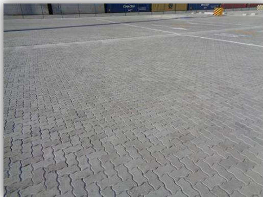
Detalhe da pavimentação externa em blocos intertravados de concreto no pátio de armazenagem de contêineres (3ª Fase – Expansão – Área C)
