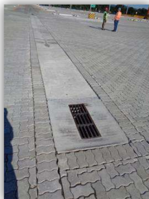
Detalhe de um dos pontos do sistema de drenagem no pátio de armazenagem de contêineres (3ª Fase – Expansão – Área C)
