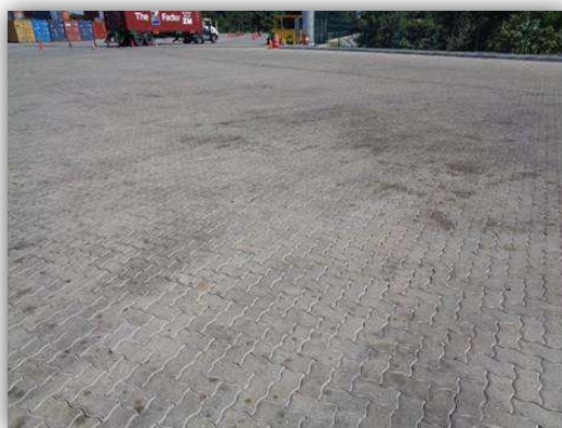
Detalhe da pavimentação com blocos intertravados de concreto no pátio de armazenagem de contêineres (3ª Fase – Expansão – Área F)
