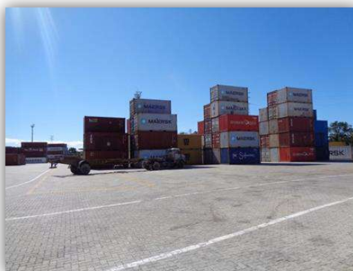
Vista parcial da área do pátio de armazenagem de contêineres (3ª Fase – Expansão – Área E)
