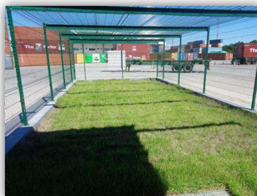
Vistas parciais internas do novo canil – K9 (Área F)
