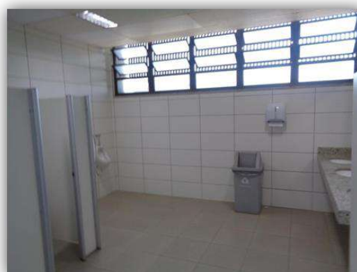
Vista parcial interna do banheiro masculino
