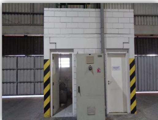
Detalhe externo dos banheiros na área do armazém de inspeção de produtos (atualmente desativado)
