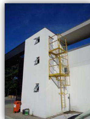
Vista parcial externa da área do banheiro, CPD e caixa d'água
