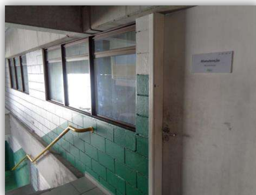
Detalhe externo das salas da administração e gestão do setor da oficina de manutenção (áreas de apoio – pavimento superior)
