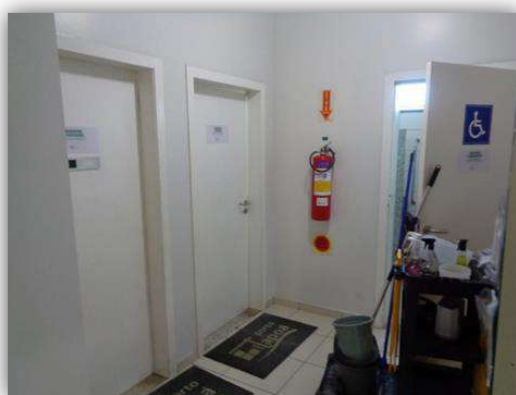
Vista parcial externa da área dos banheiros para suporte aos motoristas (prédio de apoio aos GATES)
