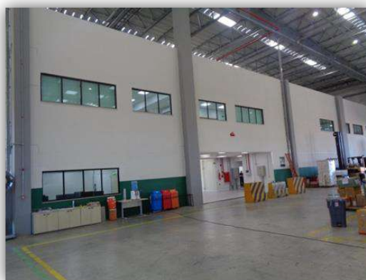
Vista parcial externa da área de apoio (escritórios) do novo armazém (3ª Fase de Expansão – Área E)
