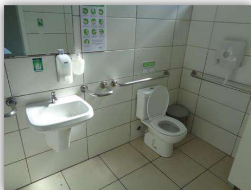
Detalhe do banheiro PNE (masculino) da área interna do refeitório
