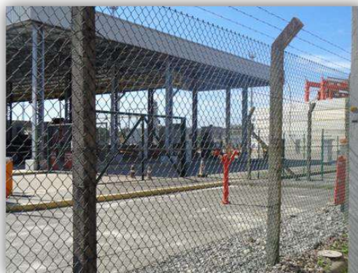
Vista parcial do fechamento da área operacional e alarme perimetral (2ª Fase – Expansão)
