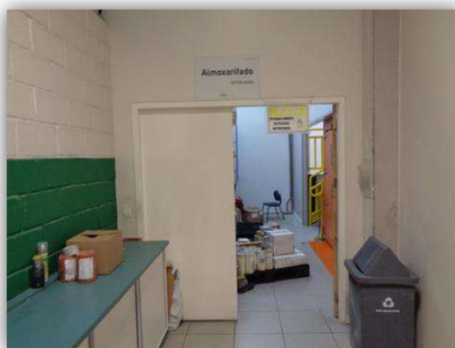
Detalhe externo da área do almoxarifado de peças de reposição da oficina (áreas de apoio – pavimento superior)
