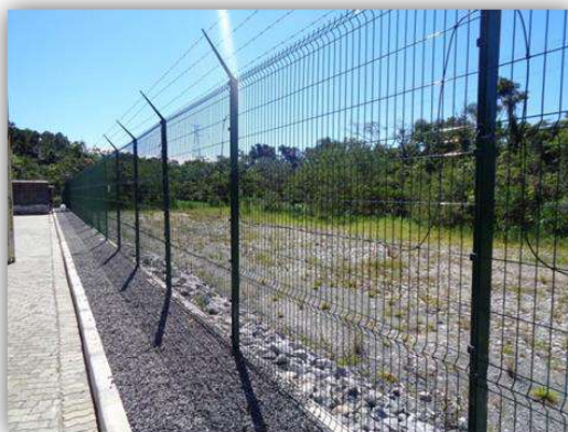
Vista parcial do fechamento da área operacional (3ª Fase – Expansão – Área F)
