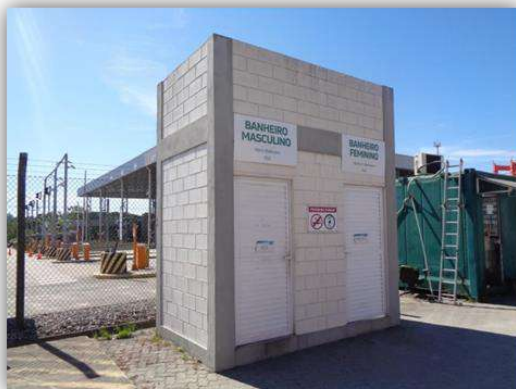
Vista parcial externa dos banheiros (área próxima aos GATES e ao pátio de armazenagem de contêineres)
