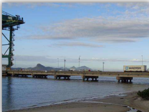
Vista parcial da ponte de acesso ao cais
