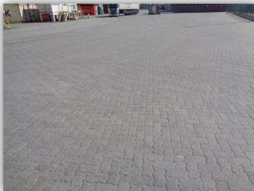
Detalhe da pavimentação externa em blocos intertravados de concreto no pátio de armazenagem de contêineres (2ª Fase - Expansão)
