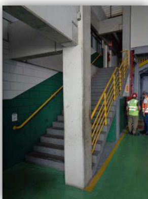
Detalhe da escada de acesso às áreas de apoio (pavimento superior)
