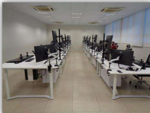
Vista parcial interna da sala de operação (Operação Remota)
