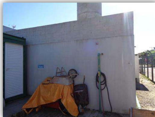
Vistas parciais da cisterna
