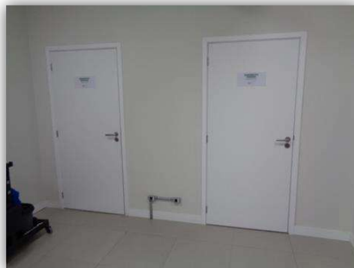
Vista externa do banheiro PCD (áreas de apoio – 1º andar)
