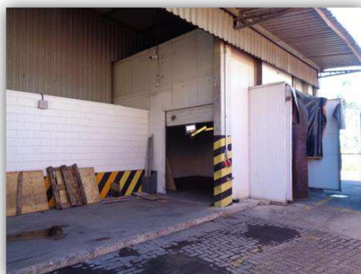
Detalhe da área do túnel retrátil para recebimento de produtos (atualmente desativada)
