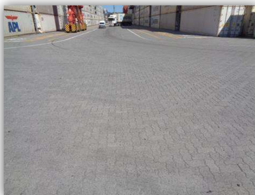
Detalhe da pavimentação externa em blocos intertravados de concreto no pátio de armazenagem de contêineres (2ª Fase - Expansão)
