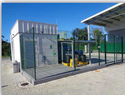
Vista externa da Estação de Tratamento de Efluentes – ETE (Área F)
