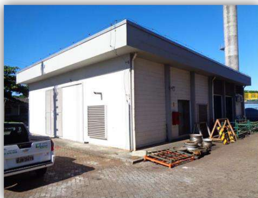
Vista parcial externa da subestação 01 (SE-01)
