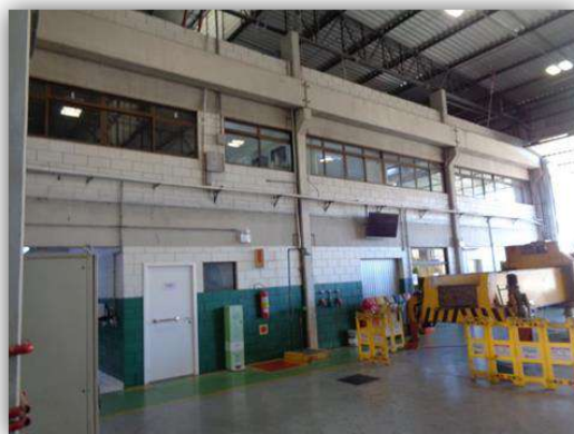
Vista parcial externa das áreas de apoio (estruturas internas) do galpão da oficina de manutenção mecânica e elétrica
