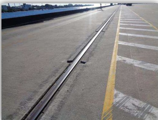
Detalhes dos novos trilhos no píer de atracação – 1ª Fase com 630,00 metros de extensão
