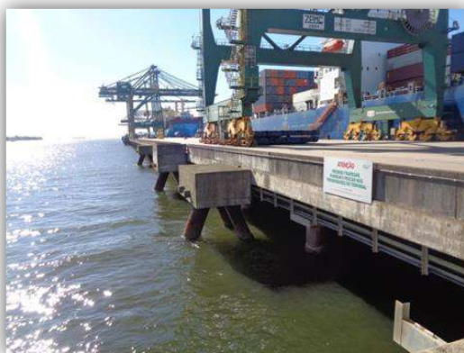
Vista parcial do píer de atracação – 1ª Fase com 630,00 metros de extensão
