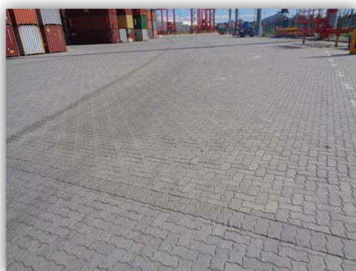
Detalhes da pavimentação externa em blocos intertravados de concreto no pátio de armazenagem de contêineres (3ª Fase – Expansão – Áreas A + B)
