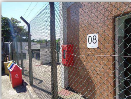
Vista parcial do fechamento da área operacional e alarme perimetral (1ª Fase – Expansão)
