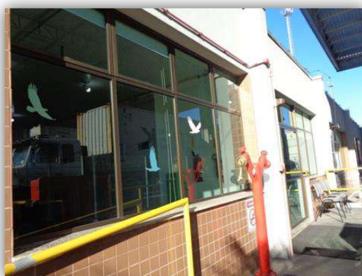
Vista parcial externa do prédio de apoio aos GATES
