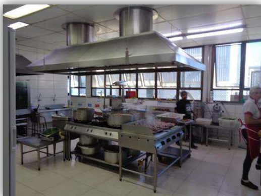
Vista parcial interna da cozinha do refeitório
