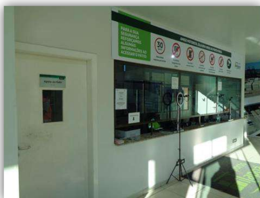
Detalhe externo da área da administração do prédio de apoio aos GATES
