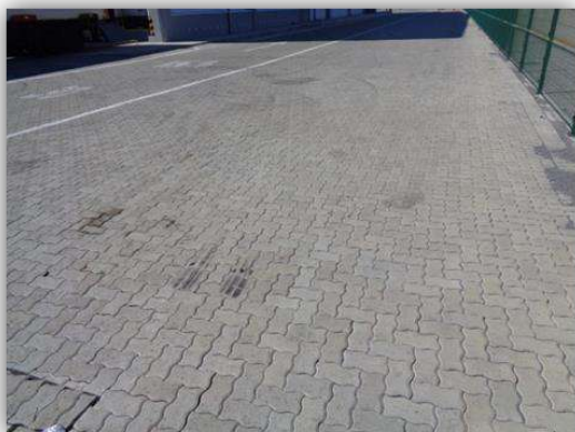
Detalhes da pavimentação com blocos intertravados de concreto no pátio de armazenagem de contêineres (3ª Fase – Expansão – Área E)
