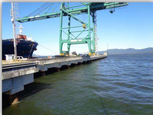
Vista parcial do píer de atracação – 2ª Fase com 170,00 metros de extensão
