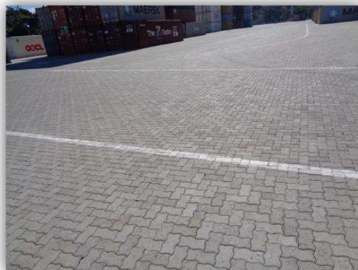
Detalhes da pavimentação com blocos intertravados de concreto no pátio de armazenagem de contêineres (3ª Fase – Expansão – Área E)
