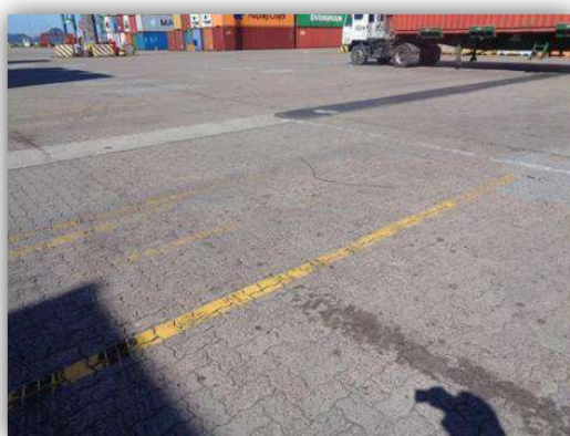
Detalhe da pavimentação externa em blocos intertravados de concreto no pátio de armazenagem de contêineres (1ª Fase)
