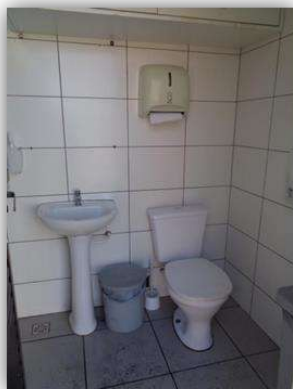
Detalhe do banheiro na área do depósito de emergência ambiental
