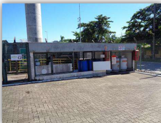
Vista parcial do abrigo para central de resíduos e cilindros de gás (área próxima ao refeitório)
