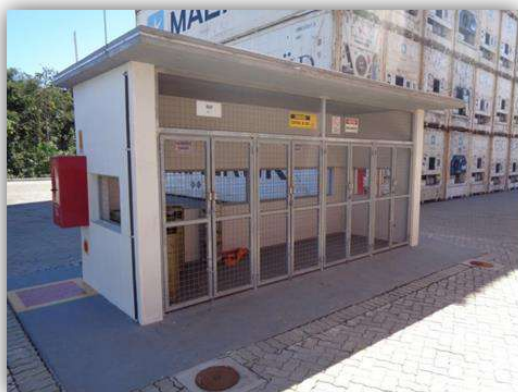
Vistas externas do abrigo para cilindros de GLP – EMPILHADEIRAS (Área F)
