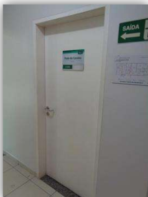
Detalhe externo da sala de reunião (prédio de apoio aos GATES)
