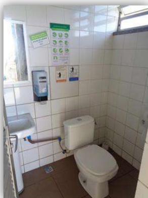
Detalhe interno do banheiro anexo à casa de bombas do sistema de combate a incêndio
