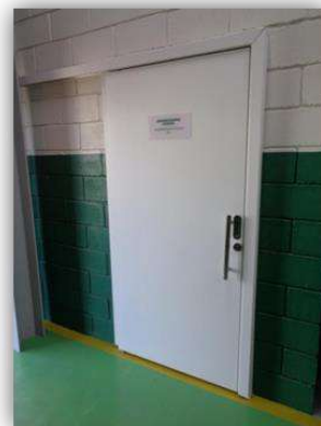
Vista externa do banheiro PCD feminino (áreas de apoio – térreo)
