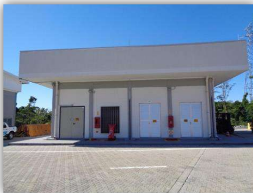
Vista parcial externa da subestação 05 (SE-05)
