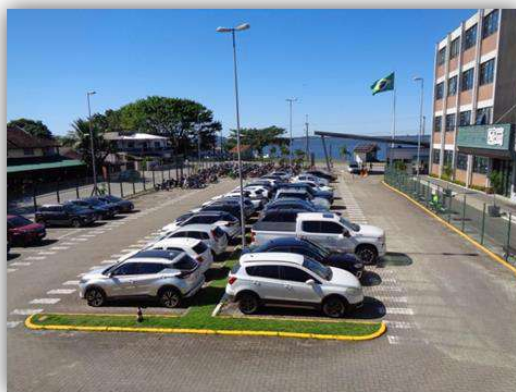
Vista parcial do imóvel avaliando (detalhe da parte frontal junto a portaria e ao prédio administrativo)
