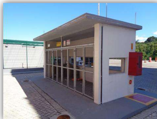
Vistas externas do abrigo para cilindros de GLP – EMPILHADEIRAS (Área F)
