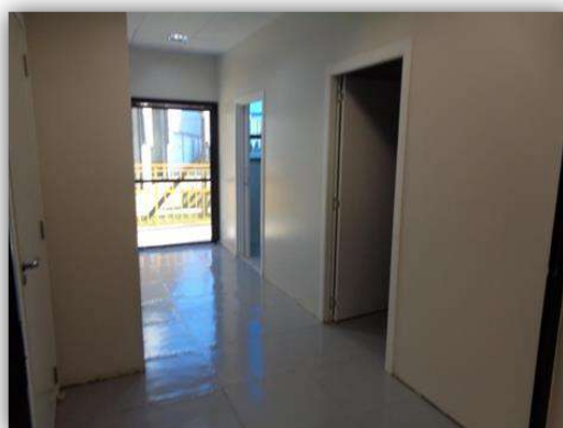
Vista parcial da área do ambulatório (em fase final de reforma)
