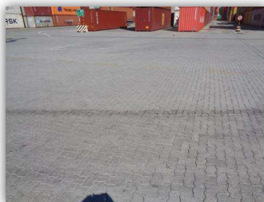
Detalhes da pavimentação externa em blocos intertravados de concreto no pátio de armazenagem de contêineres (3ª Fase – Expansão – Áreas A + B)
