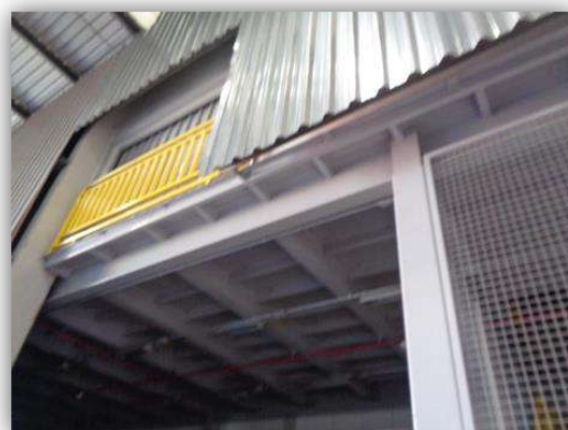
Detalhe do novo mezanino na área do almoxarifado de produtos perigosos
