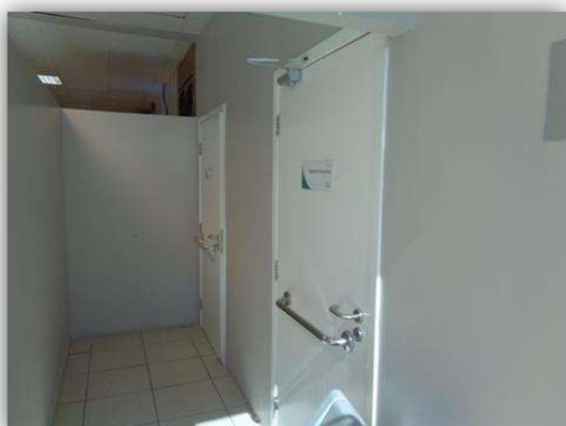
Detalhe do acesso aos banheiros PNE (masculino e feminino) da área interna do refeitório
