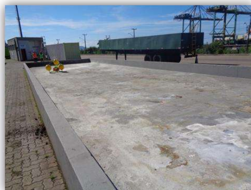
Vistas parciais da bacia de contenção (área próxima ao depósito de emergência ambiental)
