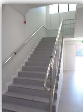
Detalhe da escada de acesso ao pavimento superior (áreas de apoio – térreo)
