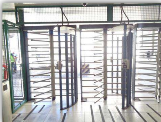
Detalhe da passagem (torniquetes) entre o prédio de apoio aos dockers e a área alfandegada
