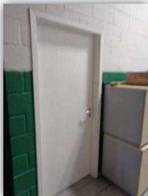
Detalhe externo da sala do planejamento e engenharia (áreas de apoio – pavimento superior)
