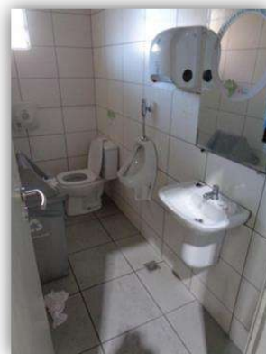
Detalhe interno do banheiro masculino na área do armazém de inspeção de produtos (atualmente desativado)
