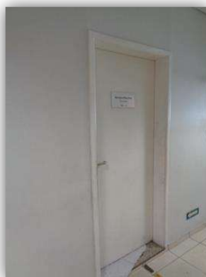
Vista parcial externa do vestiário masculino (prédio de apoio aos dockers)
