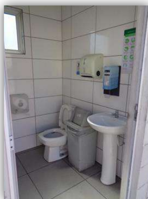
Vista parcial interna do banheiro masculino (área próxima aos GATES e ao pátio de armazenagem de contêineres)
