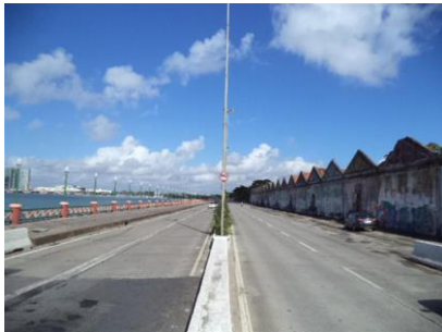
Vista para o bloco vinho
