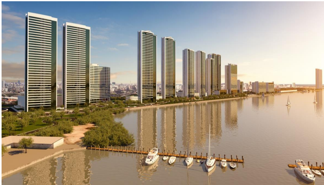
Perspectiva das 10 torres do empreendimento
