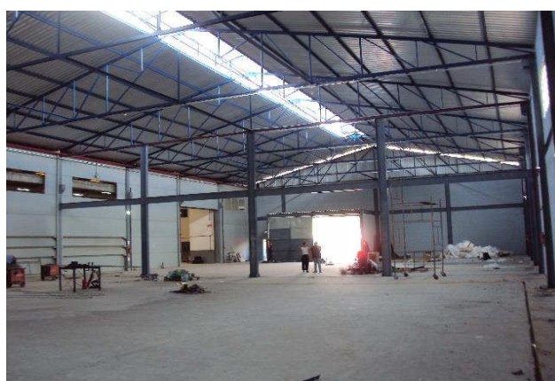
VISTA INTERNA DO IMÓVEL (GALPÃO AMPLIAÇÃO)
