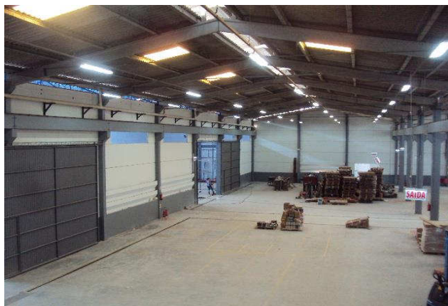
VISTA INTERNA DO IMÓVEL - GALPÃO (EXISTENTE)
