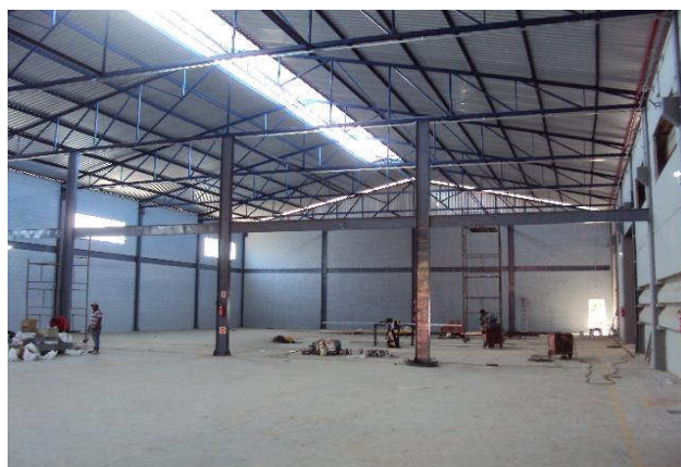
VISTA INTERNA DO IMÓVEL (GALPÃO AMPLIAÇÃO)
