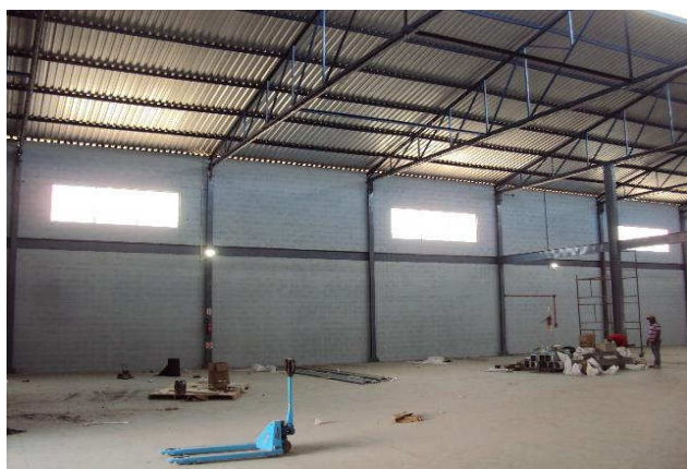
VISTA INTERNA DO IMÓVEL (GALPÃO AMPLIAÇÃO)
