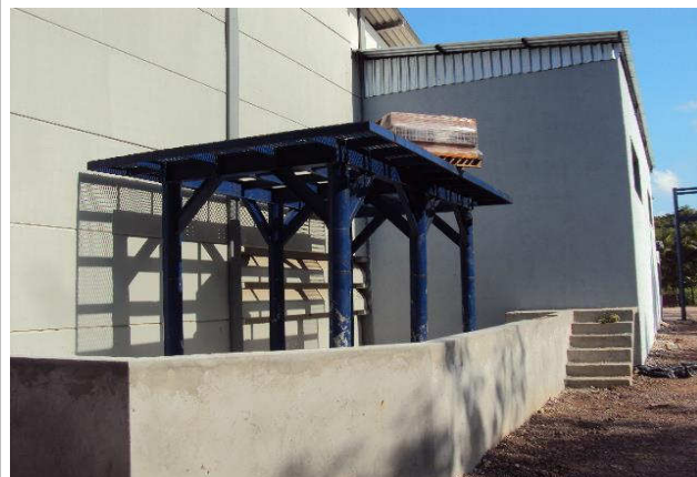
VISTA EXTERNA AMPLIAÇÃO FUNDOS (GALPÃO EXISTENTE)
