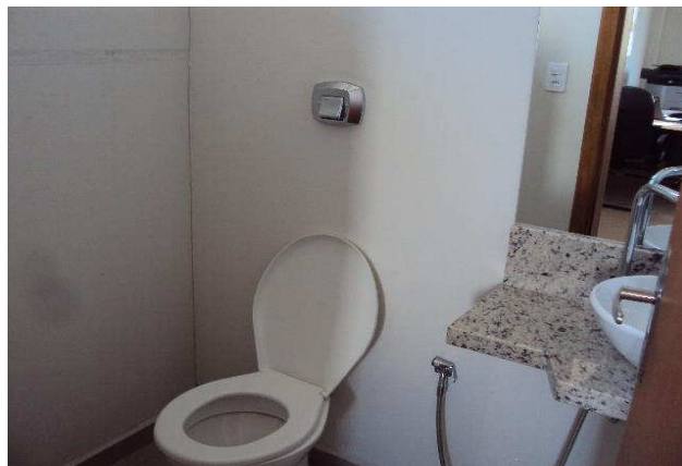
VISTA INTERNA DO IMÓVEL - MEZANINO (GALPÃO EXISTENTE)
