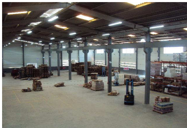
VISTA INTERNA DO IMÓVEL - GALPÃO (EXISTENTE)
