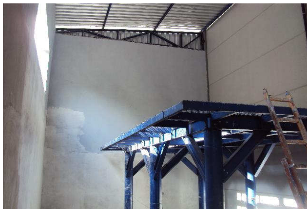
VISTA INTERNA AMPLIAÇÃO FUNDOS (GALPÃO EXISTENTE)
