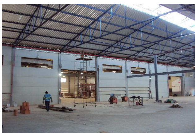
VISTA INTERNA DO IMÓVEL (GALPÃO AMPLIAÇÃO)
