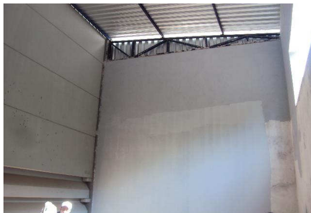
VISTA INTERNA AMPLIAÇÃO FUNDOS (GALPÃO EXISTENTE)
