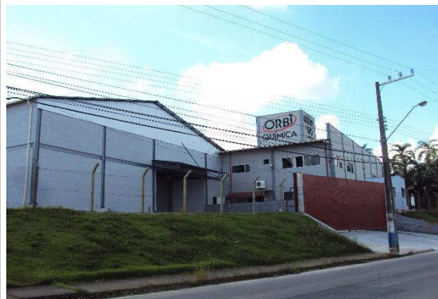
VISTA EXTERNA DO IMÓVEL
