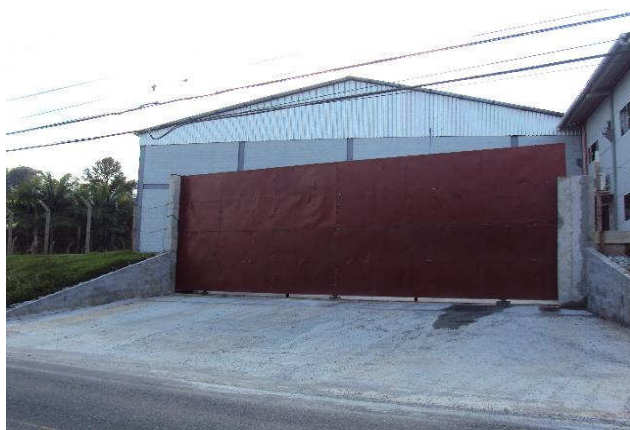
PORTÃO DE ACESSO A DOCA (GALPÃO AMPLIAÇÃO)
