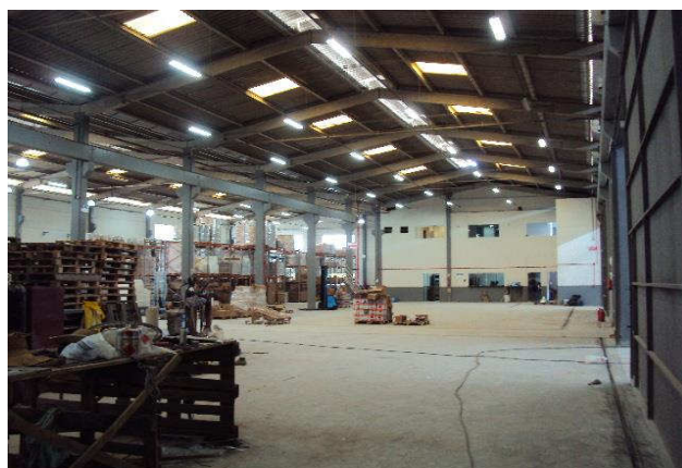
VISTA INTERNA DO IMÓVEL - GALPÃO (EXISTENTE)
