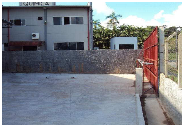
VISTA EXTERNA DO IMÓVEL - DOCA (GALPÃO AMPLIAÇÃO)
