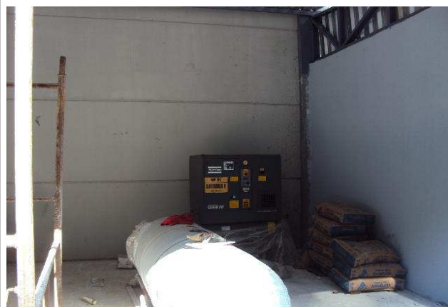
VISTA INTERNA AMPLIAÇÃO FUNDOS (GALPÃO EXISTENTE)
