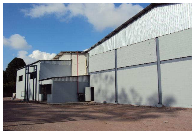
VISTA GERAL EXTERNA FUNDOS DOS GALPÕES
