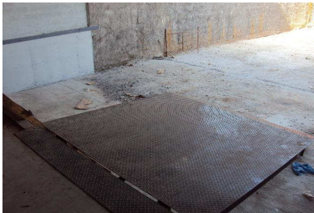
VISTA INTERNA DO IMÓVEL - DOCA (GALPÃO AMPLIAÇÃO)
