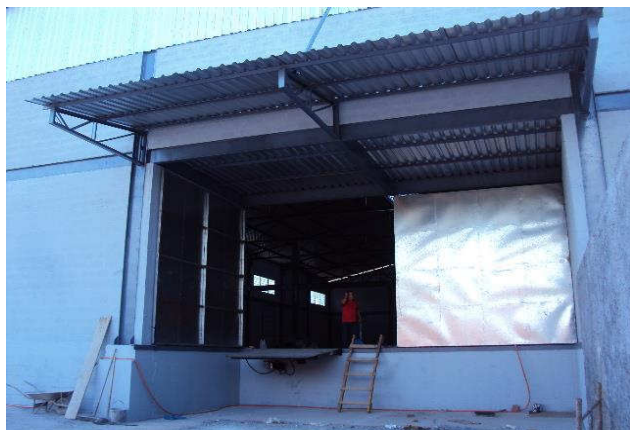
VISTA EXTERNA DO IMÓVEL - DOCA (GALPÃO AMPLIAÇÃO)
