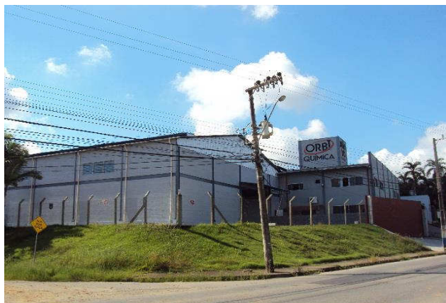
VISTA EXTERNA DO IMÓVEL
