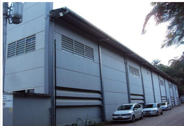
VISTA EXTERNA DO GALPÃO (GALPÃO EXISTENTE)
