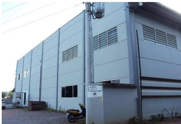
VISTA EXTERNA DO GALPÃO (GALPÃO EXISTENTE)
