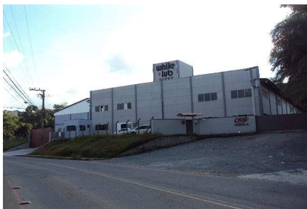
VISTA EXTERNA DO IMÓVEL
