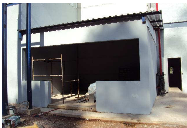
VISTA EXTERNA AMPLIAÇÃO FUNDOS (GALPÃO EXISTENTE)
