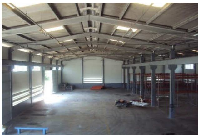
VISTA INTERNA DO IMÓVEL - GALPÃO
