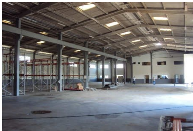
VISTA INTERNA DO IMÓVEL - GALPÃO
