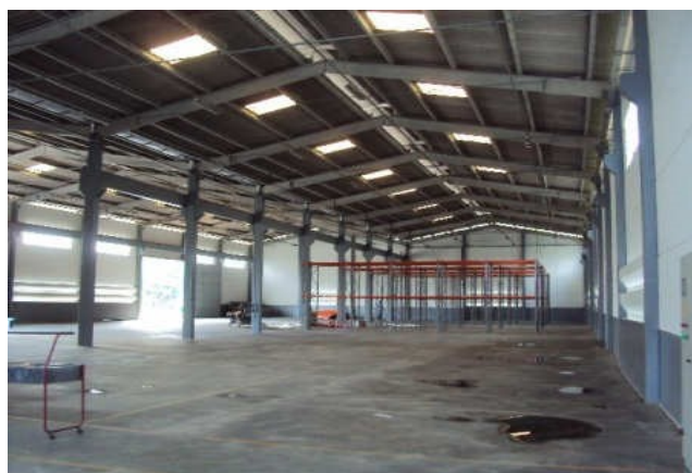
VISTA INTERNA DO IMÓVEL - GALPÃO
