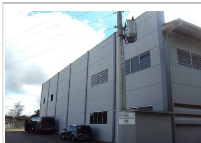
VISTA EXTERNA DO GALPÃO
