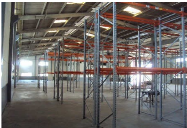
VISTA INTERNA DO IMÓVEL - GALPÃO
