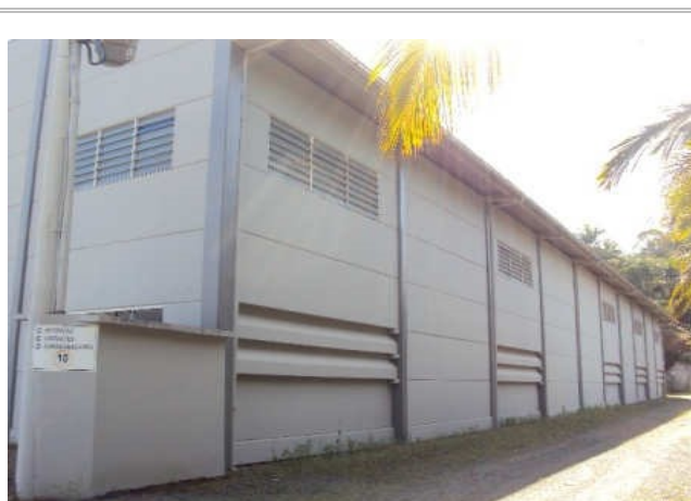
VISTA EXTERNA DO GALPÃO
