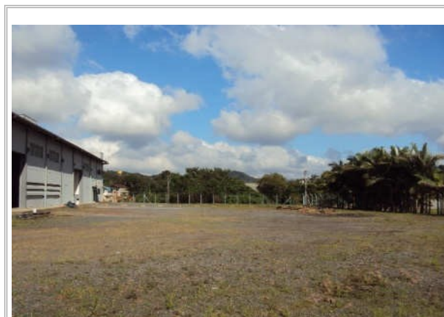
VISTA GERAL INTERNA DO TERRENO
