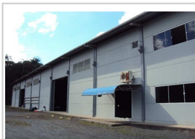
VISTA EXTERNA DO GALPÃO
