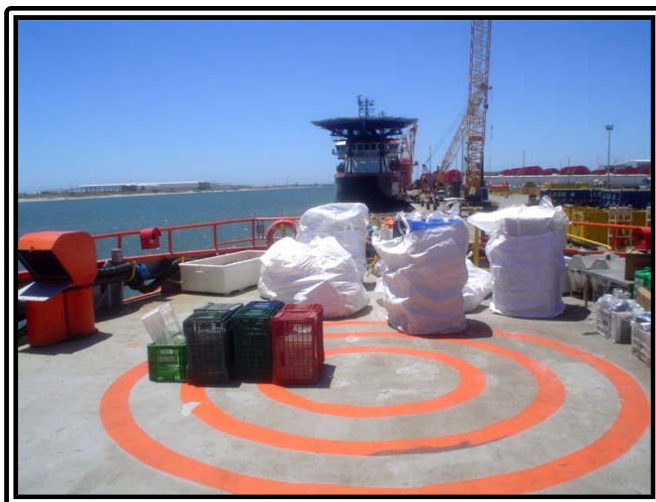
FOTO Nº 04:- CONVÉS SUPERIOR - VISTA GERAL DA PROA
