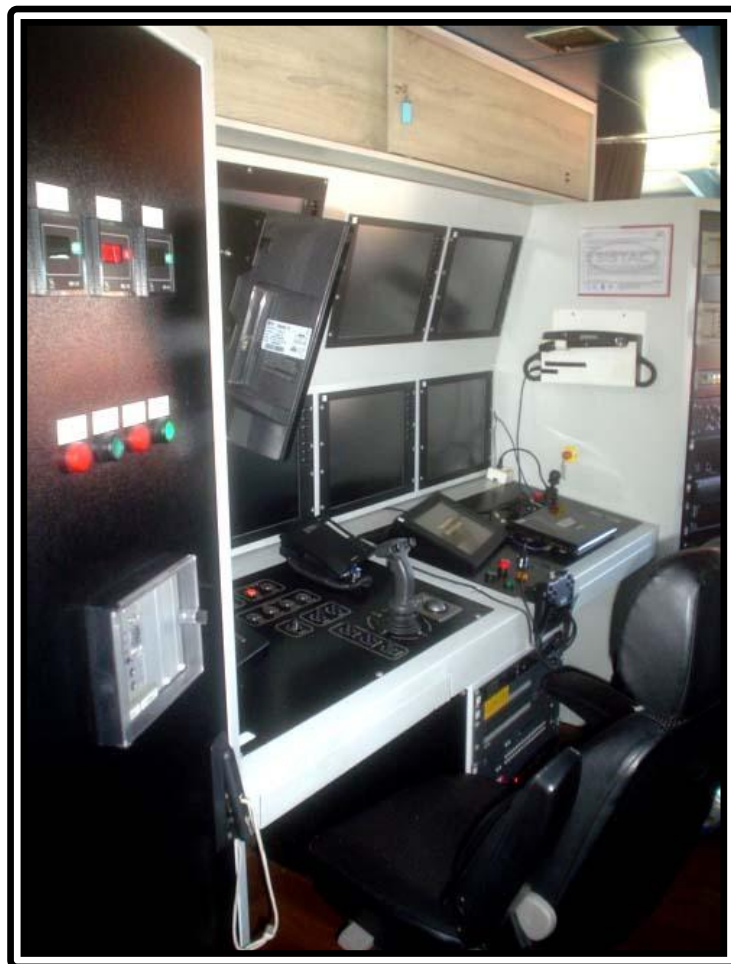
FOTO Nº 17:- PASSADIÇO – OUTRO ÂNGULO CENTRAL CONTROLE E MONIT. ROV “ATOM” - BORESTE
