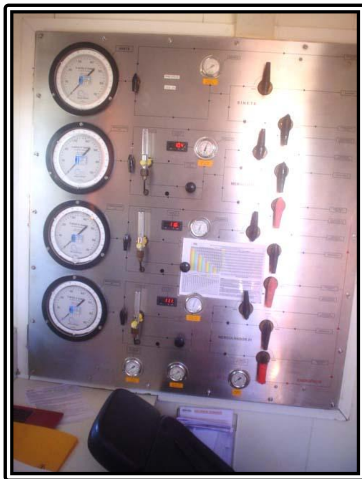
FOTO Nº 54:- CONVÉS SUPERIOR – PAINEL DE CONTROLE DOS MERGULHADORES
