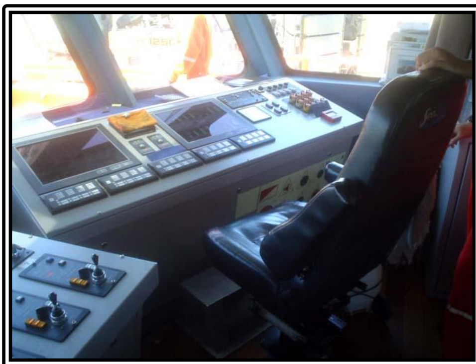
FOTO Nº 13:- PASSADIÇO – MONITORAMENTO GERENCIAMENTO NAVEGAÇÃO “BÖNING” / “DEIF”
