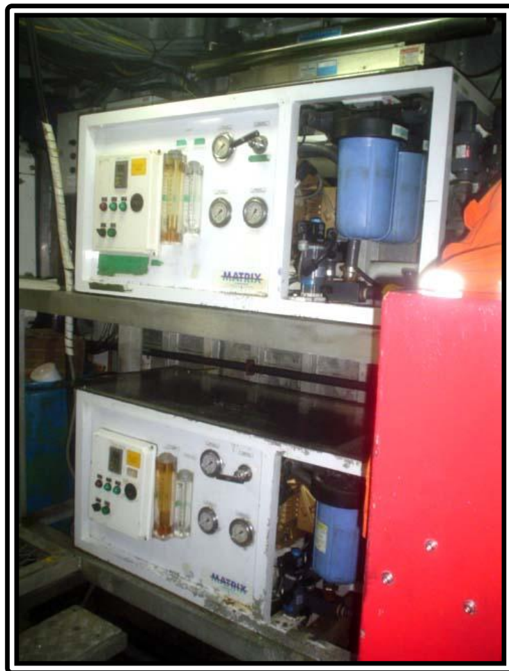
FOTO Nº 34:- CONVÉS INFERIOR – DESSALINIZADORES MARCA “MATRIX”
