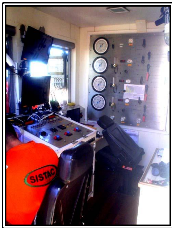
FOTO Nº 52:- CONVÉS SUPERIOR – SALA DE COMANDO E MONITORAMENTO MERGULHO
