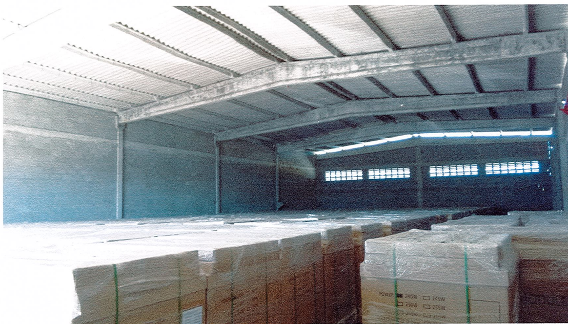
Foto 3.3.1 – Vista do galpão da filial São Gonçalo
