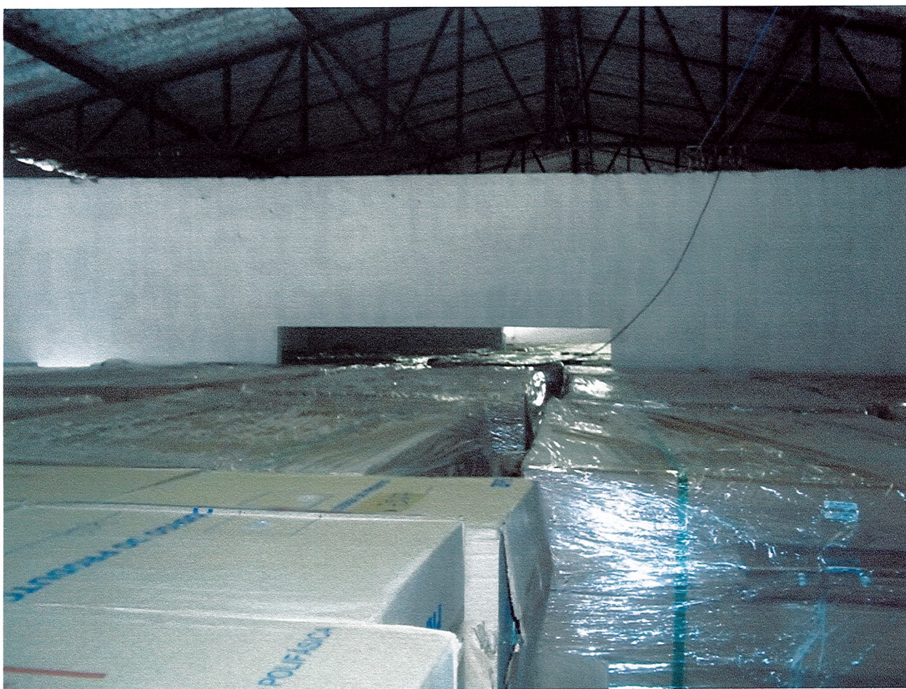
Foto 3.2.2 – Vista do setor C do galpão de Teresina
