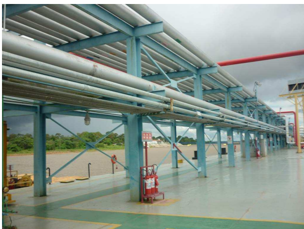
Vista do Cais Flutuante e duto-vias
