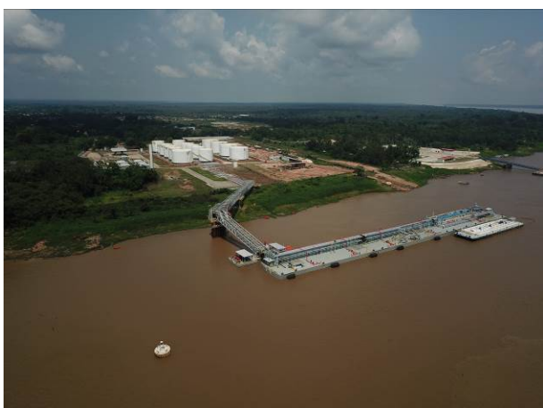
Vista Aérea do empreendimento e interligação Ao terminal flutuante (2018)
