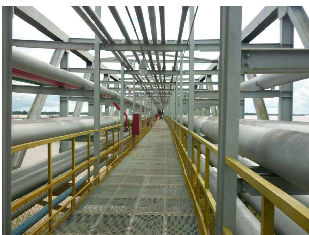
Estrutura metálica da passarela e duto-vias
