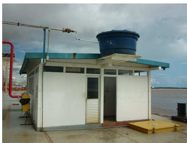
Área de apoio do Cais Flutuante
