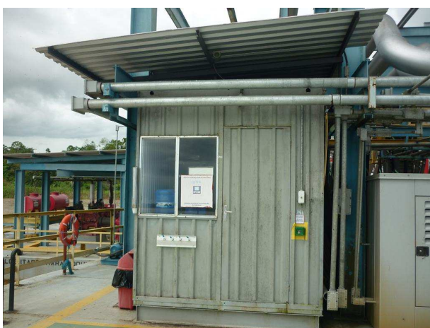
Área de apoio do Cais Flutuante
