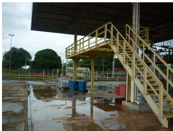
Plataforma de Carregamento
