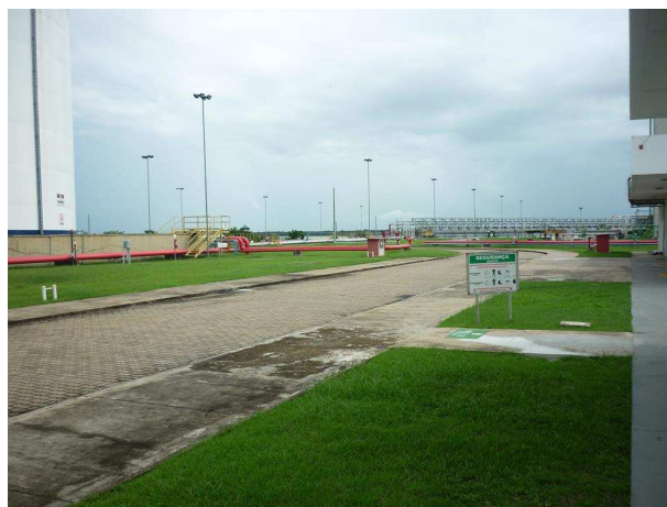
Circulação – Piso intertravado
