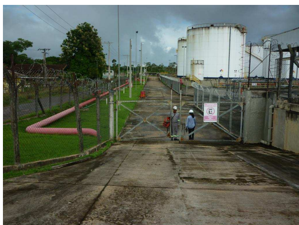
Acesso a Bacia 2 dos Tanques de combustíveis
