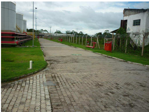
Vista lateral da bacia 2
