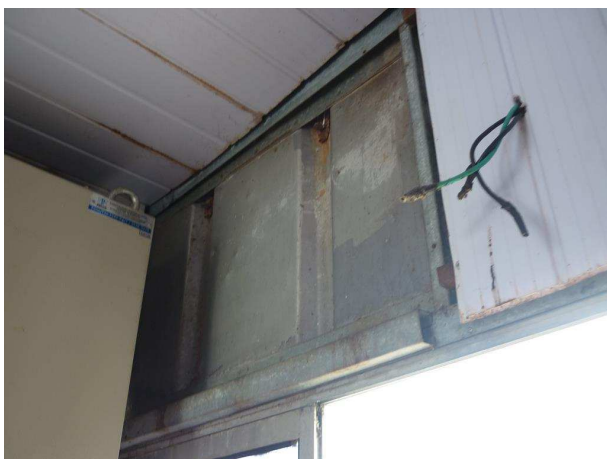
Área de apoio do Cais Flutuante
