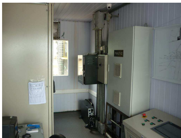
Área de apoio do Cais Flutuante
