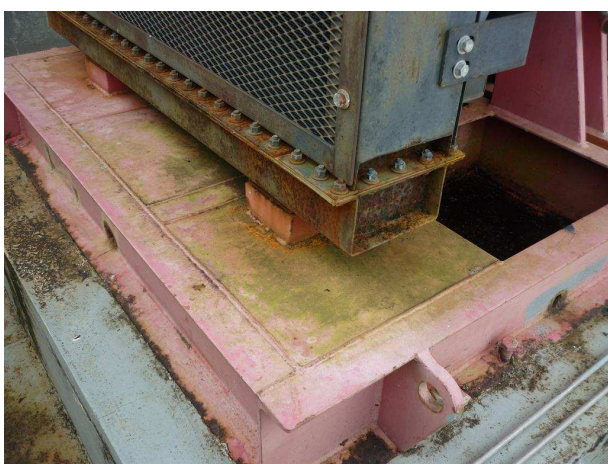
Área de apoio do Cais Flutuante
