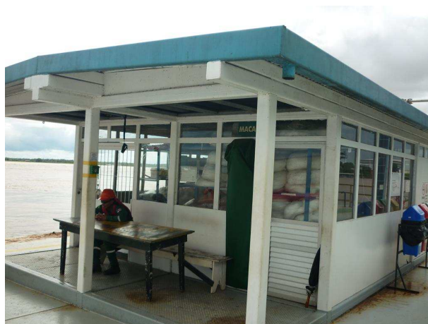
Área de apoio do Cais Flutuante
