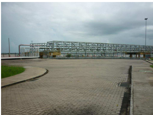
Estrutura metálica da passarela e duto-vias
