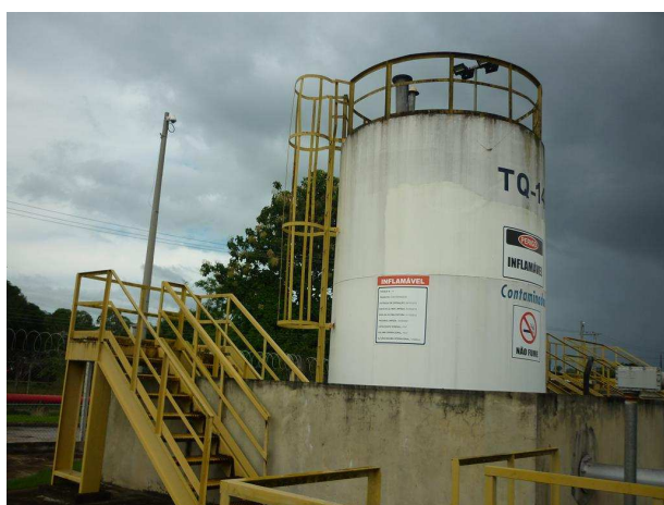
Tanque 14 - Contaminados B
