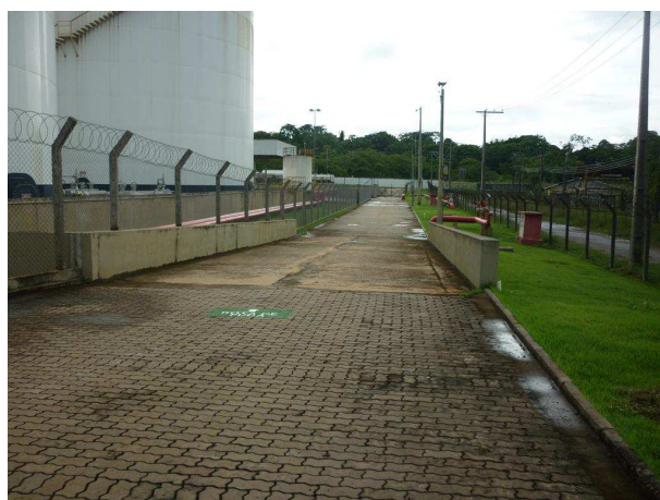
Circulação interna intertravado
