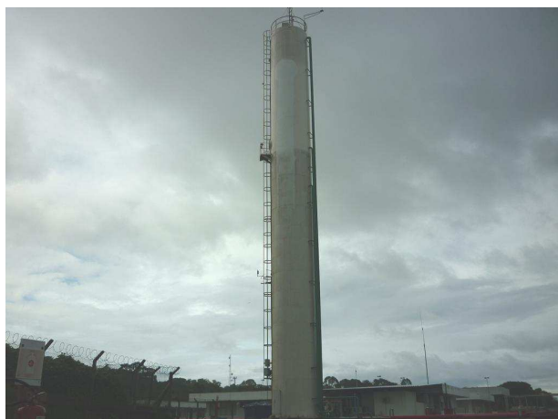
Reservatório elevado de água
