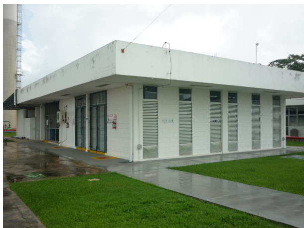
Bloco Central de Utilidade
