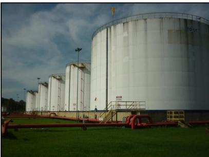
**Bacia de contenção 1:** Composta por 12 Tanques de armazenamento de combustíveis.
