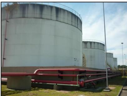
**Bacia de contenção 2:** Composta por 4 Tanques de armazenamento de combustíveis
