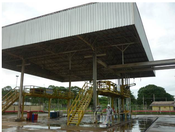
Plataforma de Carregamento
