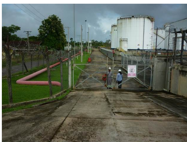
Acesso a Bacia 2 dos Tanques de combustíveis
