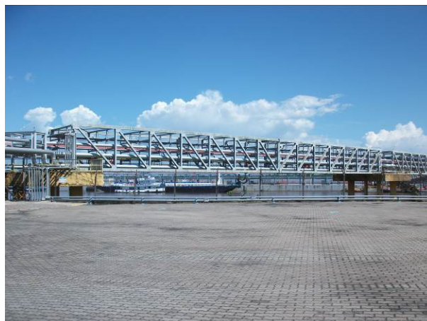
Vista da passarela metálica das dutovias
