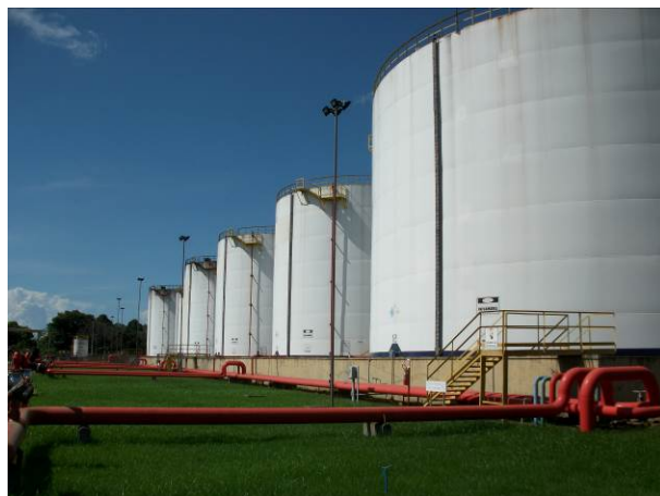
Bacia de contenção dos tanques 1
