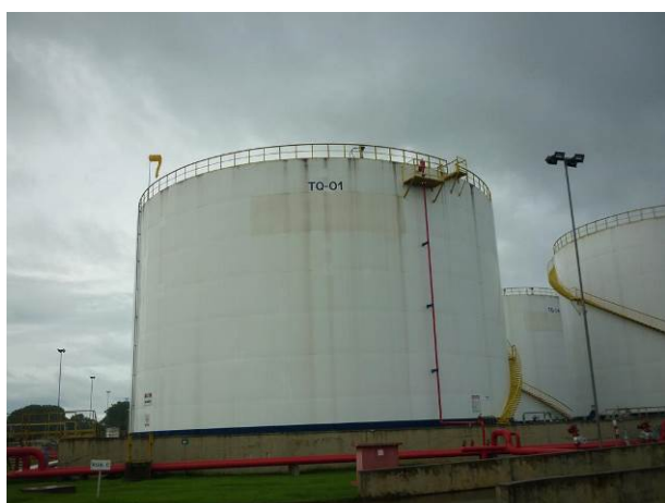
Bacia 1 – Contenção e abrigo de Tanques
