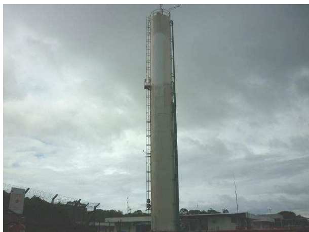
Reservatório elevado de água
