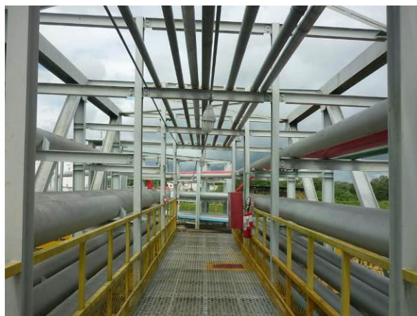
Estrutura metálica da passarela e duto-vias
