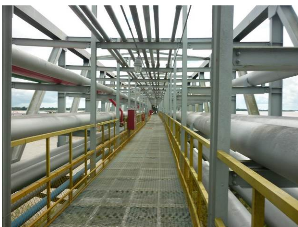
Estrutura metálica da passarela e duto-vias
