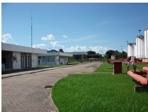
Bacia de contenção dos tanques 2
