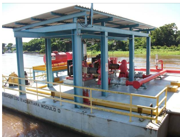
Abrigo do flutuante do grupo motor-bomba e gerador do sistema de combate a incêndio
