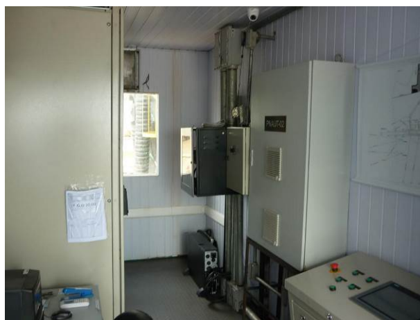
Área de apoio do Cais Flutuante
