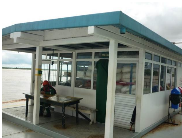
Área de apoio do Cais Flutuante
