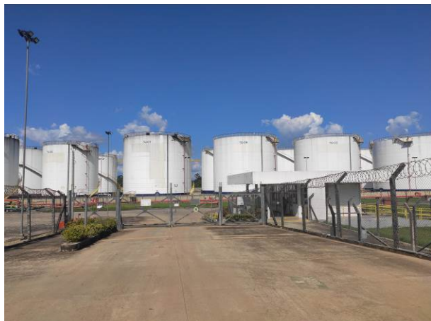
Vista da via de acesso ao empreendimento
