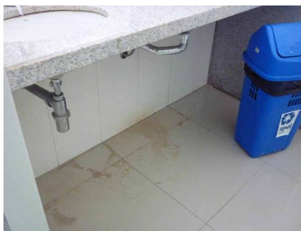
Banheiro da Administração
