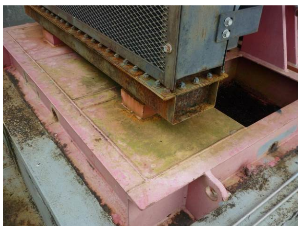
Área de apoio do Cais Flutuante
