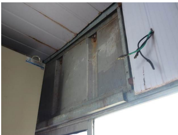
Área de apoio do Cais Flutuante
