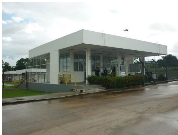
Fachada da Portaria
