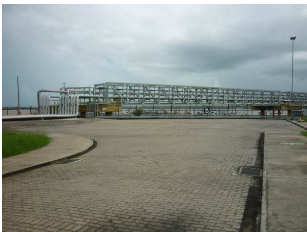
Estrutura metálica da passarela e duto-vias
