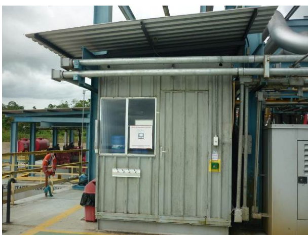
Área de apoio do Cais Flutuante
