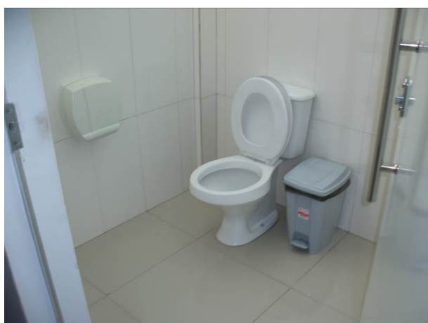
Banheiro do refeitório
