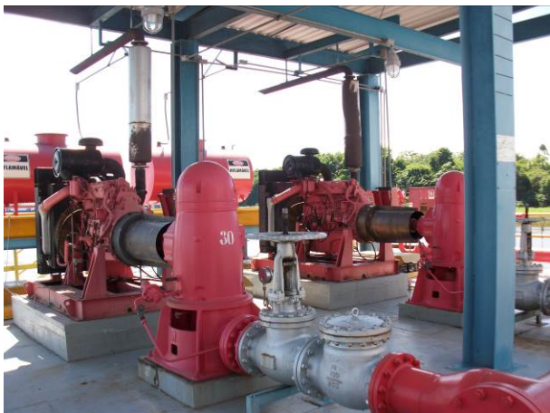
Abrigo do flutuante do grupo motor-bomba e gerador do sistema de combate a incêndio
