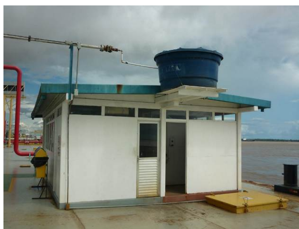
Área de apoio do Cais Flutuante
