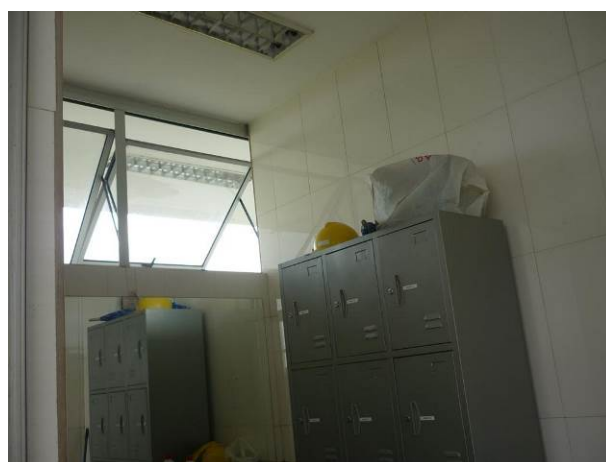
Vestiário da Portaria
