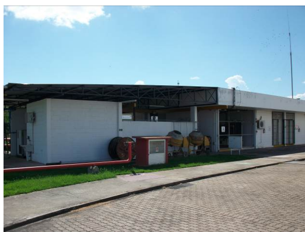
Bloco da Manutenção
