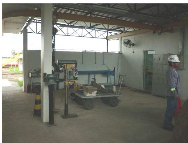
Área de manutenção
