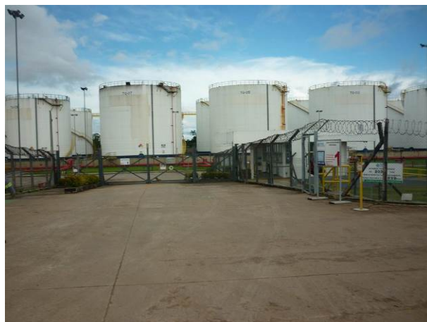
Vista da via de acesso ao empreendimento
