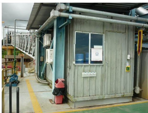
Área de apoio do Cais Flutuante
