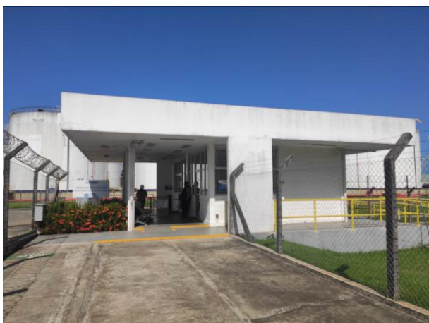
Portaria e controle de acesso a área operacional
