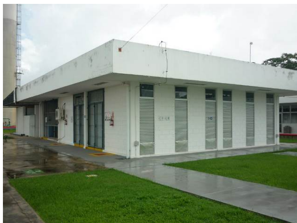
Bloco Central de Utilidade
