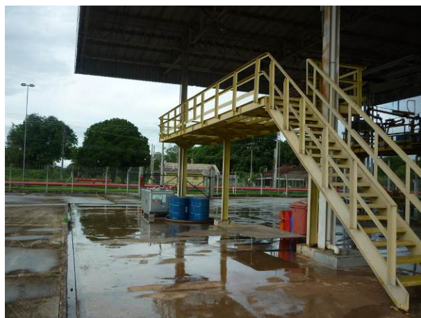
Plataforma de Carregamento
