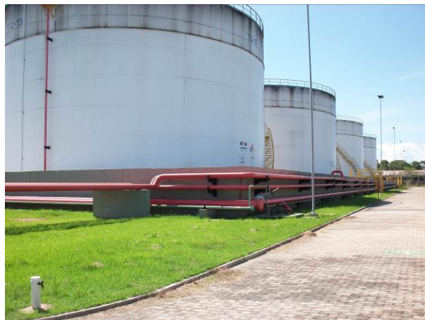
Bacia de contenção dos tanques 2
