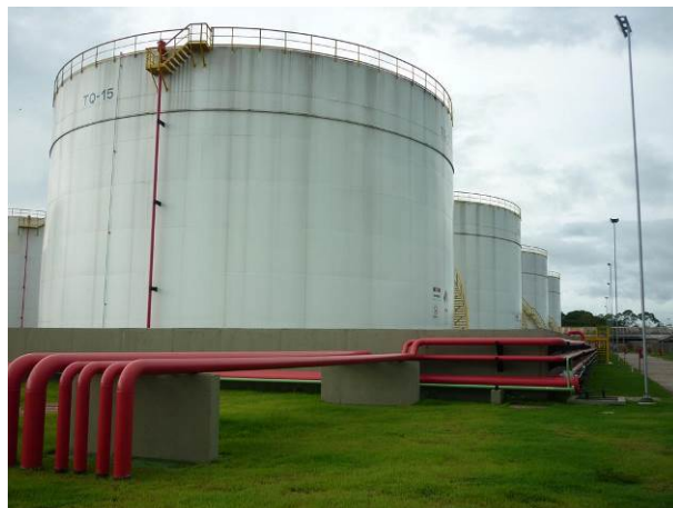
Vista da Bacia 2 e Tanques
