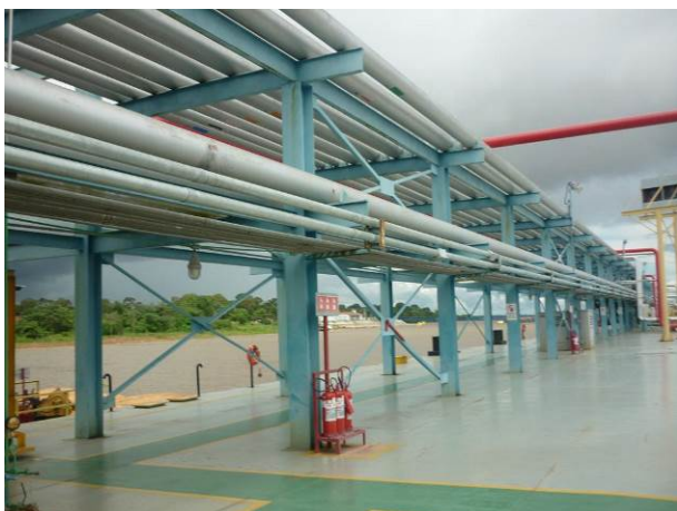
Vista do Cais Flutuante e duto-vias
