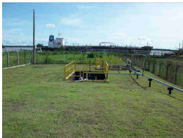
Caixa separadora "C"
