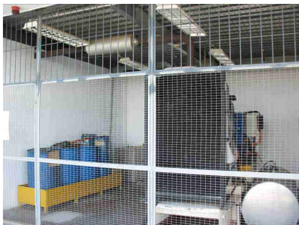
Casa do gerador
