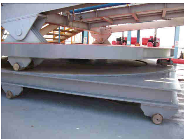
Sistema de movimentação da dutovia aérea
