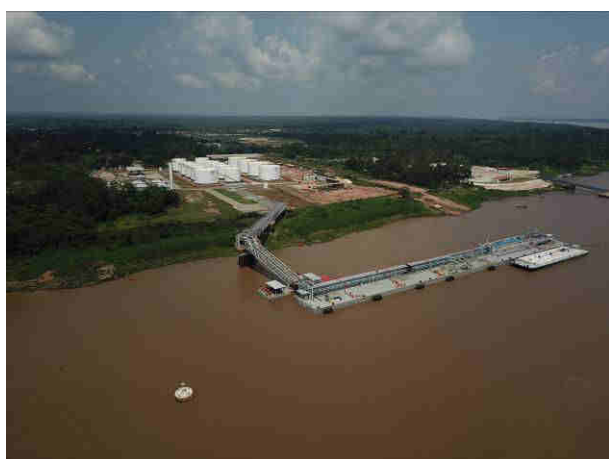
Vista Aérea do empreendimento e interligação Ao terminal flutuante
