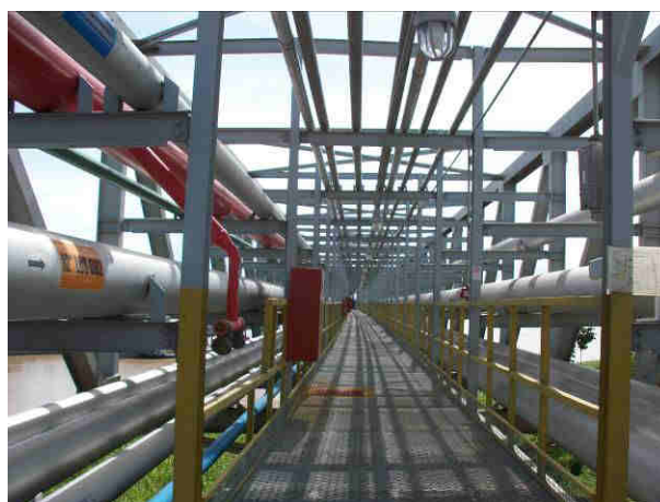
Estrutura metálica da passarela e dutovias
