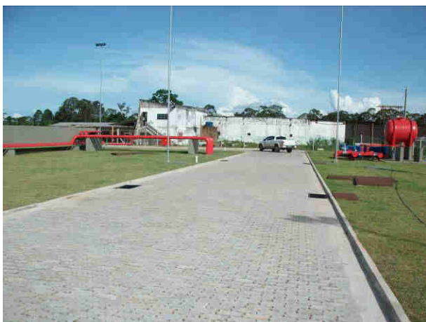
Circulação interna intertravado
