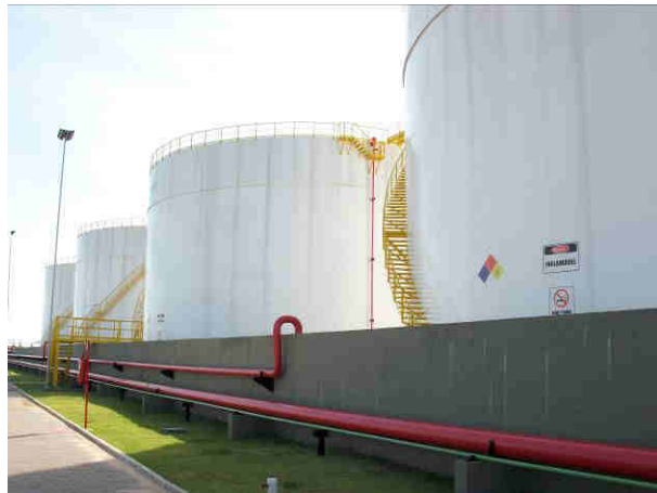
Vista lateral da bacia 2
