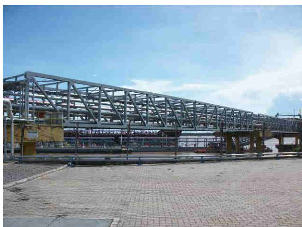
Estrutura metálica da passarela e dutovias
