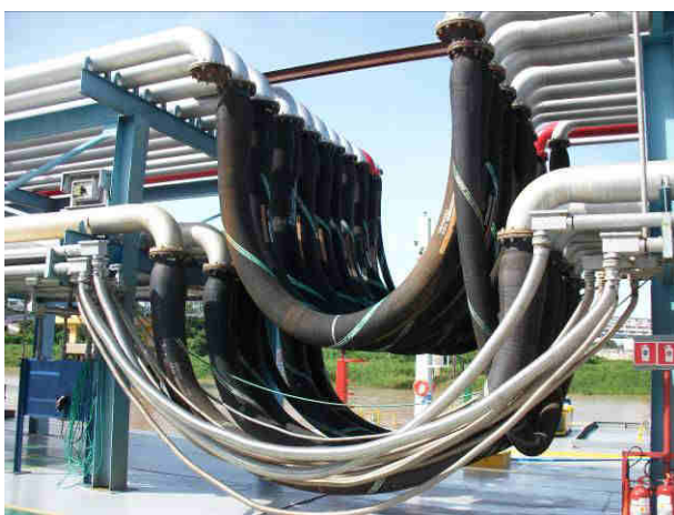
Ponto de interligação entre os módulos do cais
