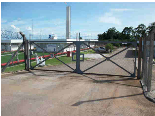
Acesso a Bacia 2 dos Tanques de combustíveis
