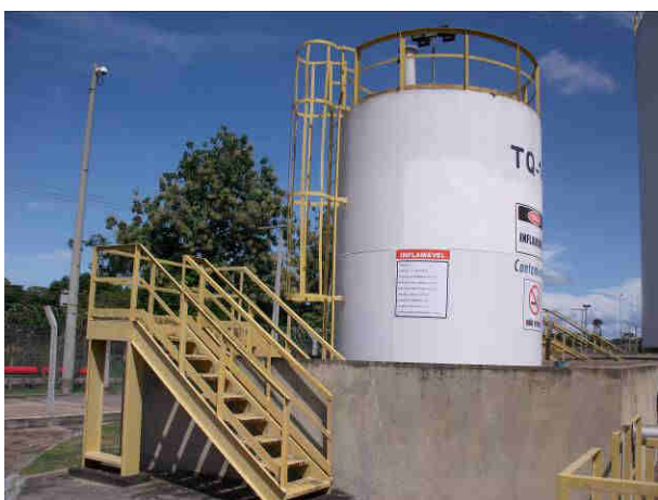
Tanque 14 - Contaminados B
