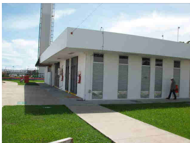
Bloco Central de Utilidades
