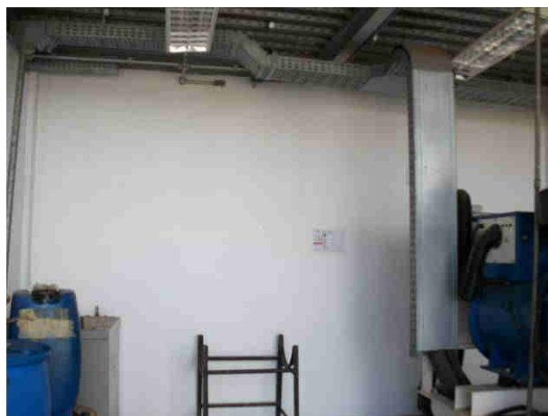
Casa do gerador
