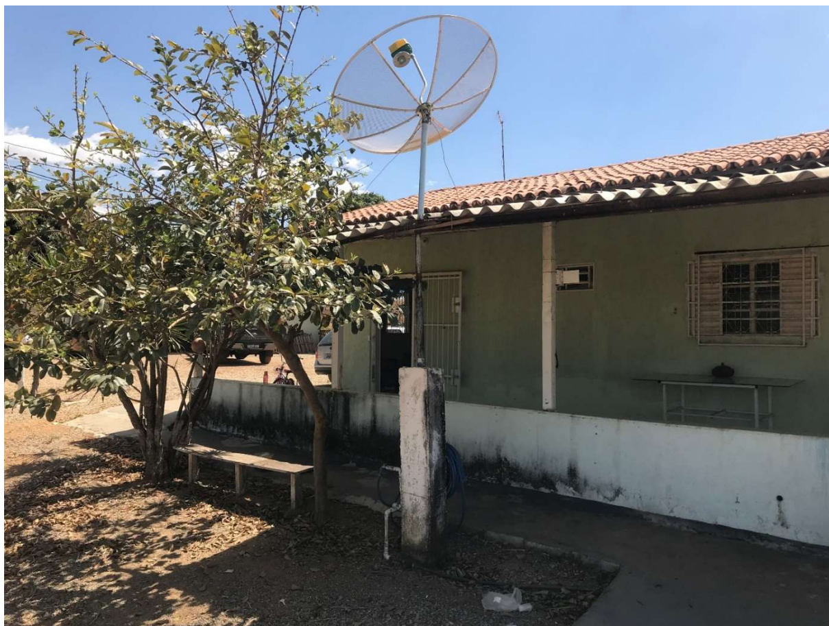
Foto 7.7 – Edificação térrea existente na propriedade e atualmente habitada.
