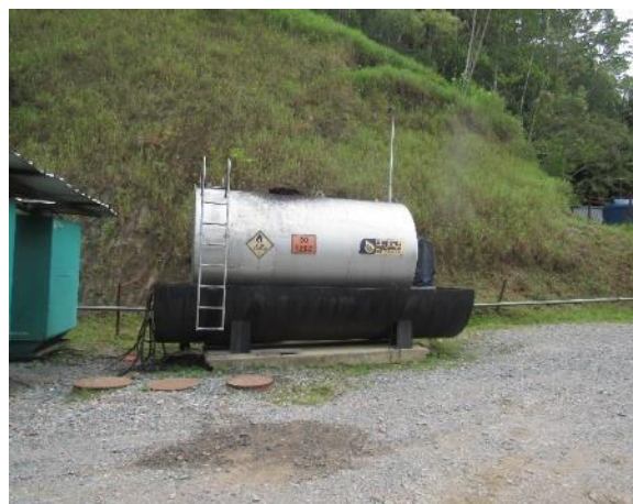
Tanque de combustível dos geradores
