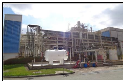
Contenções dos reservatórios
