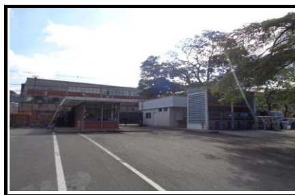
Portaria (Avenida Monteiro Lobato)
