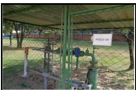
Detalhe poço ( captação de água )
