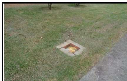
Detalhe pontos de monitoramento
