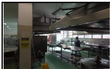
Vista para cozinha
