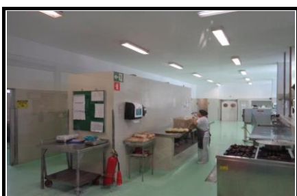
Vista para cozinha
