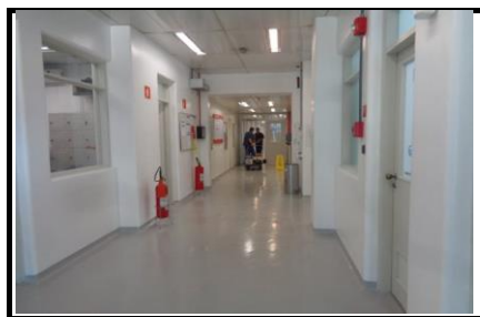
Hall de acesso ( operações de qualidade )
