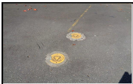
Detalhe pontos de monitoramento
