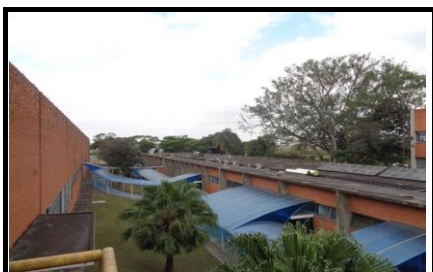
Vista prédio refeitório
