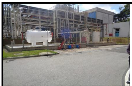
Contenções dos reservatórios
