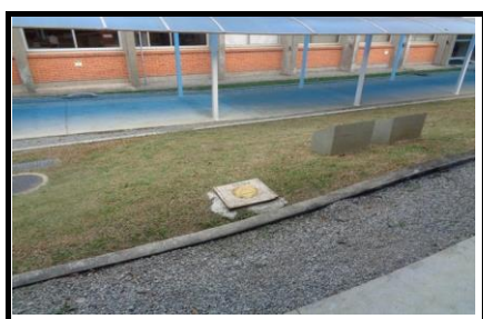
Detalhe pontos de monitoramento
