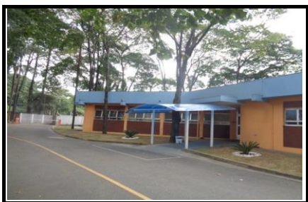
Vista para o acesso da creche
