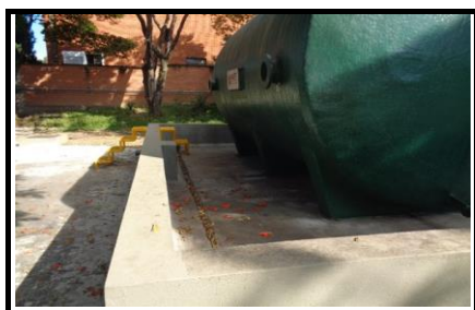
Contenções dos reservatórios
