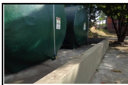
Contenções dos reservatórios
