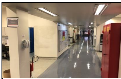
Hall de acesso
