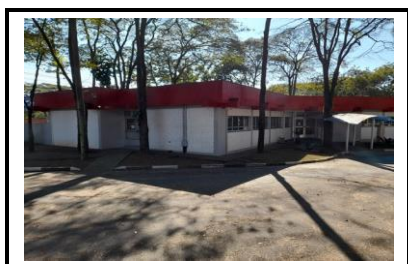
Vista da creche
