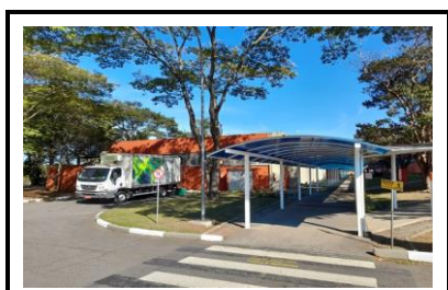
Vista corredor de acesso refeitório
