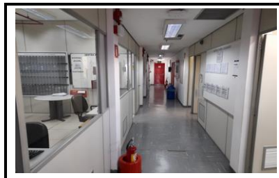
Vista corredor de circulação
