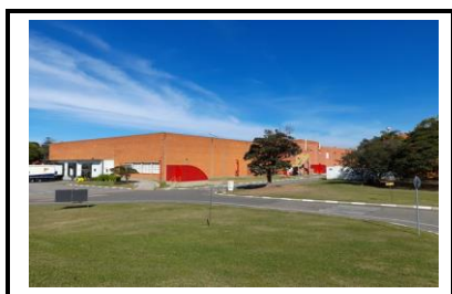
Vista gerais áreas de circulação
