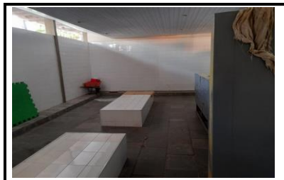
Vista interna vestiários
