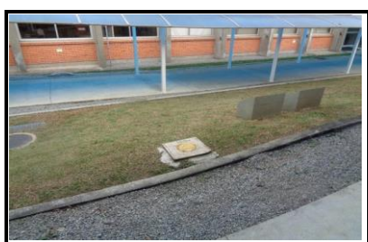
Detalhe pontos de monitoramento
