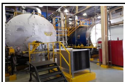
Vista interna casa caldeiras
