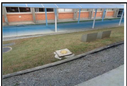
Detalhe pontos de monitoramento
