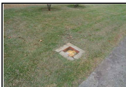
Detalhe pontos de monitoramento
