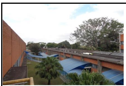
Vista prédio refeitório
