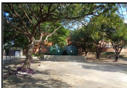
Contenções dos reservatórios
