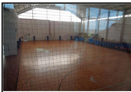
Detalhe quadra poliesportiva
